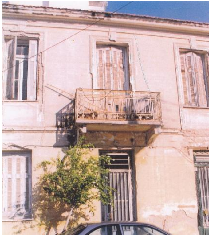
Εικόνα 3.1: Η κατοικία πριν την αποκατάσταση.
