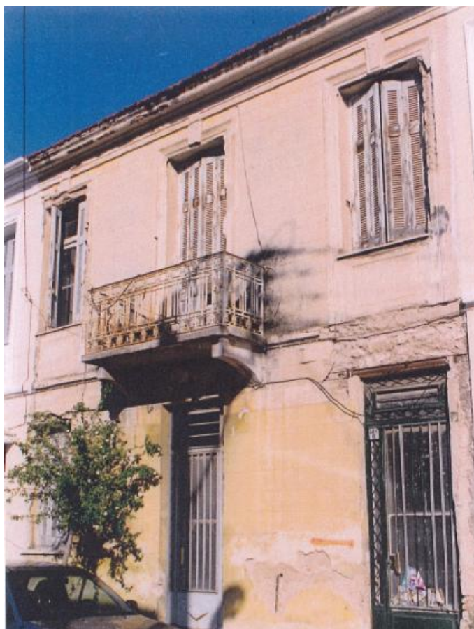
Εικόνα 3.2: Η κατοικία πριν την αποκατάσταση.
