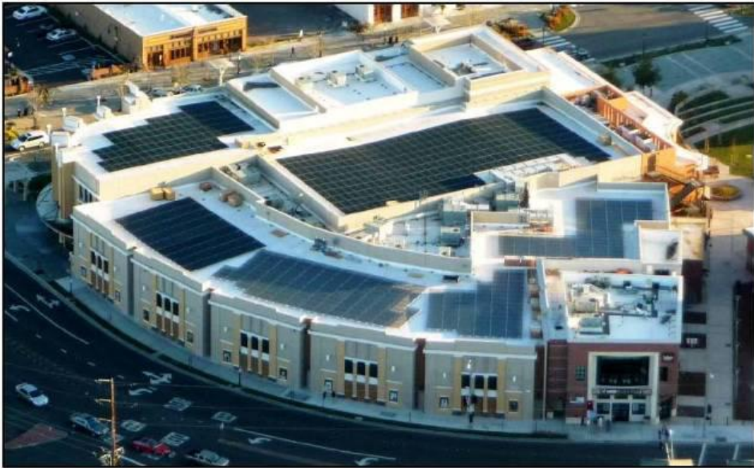
135 kW εγκατάσταση σε εμπορικό κέντρο στην Καλιφόρνια
