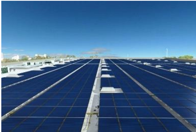
Εγκατάσταση κυλινδρικού συστήματος φωτοβολταϊκών στον Ασπρόπυργο
