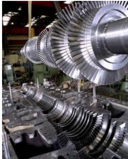
Εικόνα 1.3 Τοποθέτηση ατμοστρόβιλου ισχύος 150 MW
