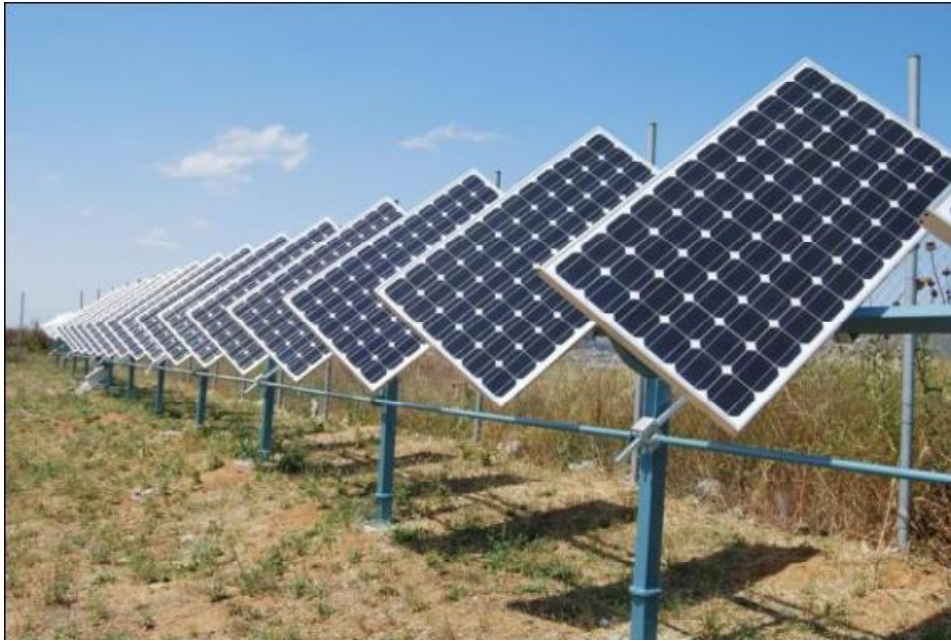
Σχήμα 7.2. Διαξονικός ηλιοστάτης μικρού ύψους (<2,5 μέτρα)
