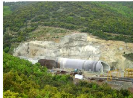
Τεχνικό Cut & Cover στομίου εισόδου σήραγγας Σ1 (Εγνατία Οδός, τμήμα 5.2-5.3)
