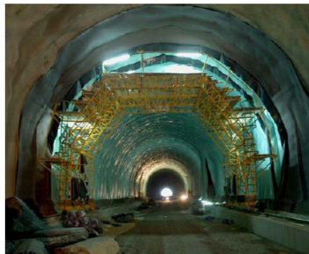
Κατασκευή τελικής επένδυσης στη σήραγγα Σ1
