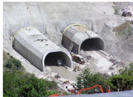
Τεχνικά Cut & Cover στομίων εισόδου σήραγγας Αγ. Νικολάου (Εγνατία Οδός, τμήμα 3.3)
