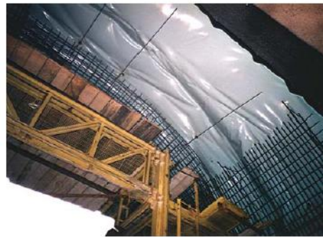
Κατασκευή τελικής επένδυσης
