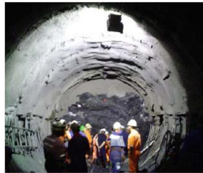
Άποψη του υπογείου μετώπου εκσκαφής
