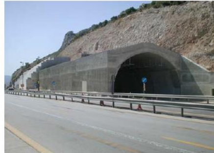
Τεχνικό Cut & Cover στομίου εισόδου σήραγγας ΑΣ1 (Αυτοκινητόδρομος ΠΑΘΕ, τμήμα Κακιά Σκάλα)
