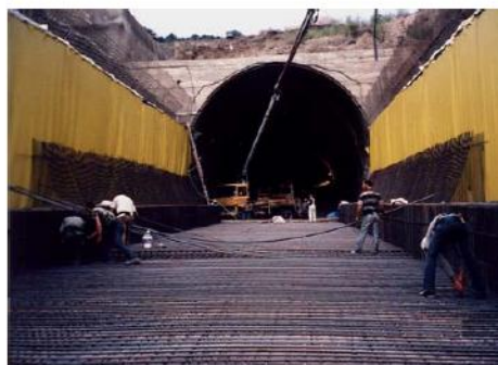
Κατασκευή Cut & Cover στο στόμιο εξόδου
