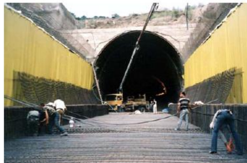
Οπλισμός πυθμένα και κατασκευή πλευρικών τοιχωμάτων
