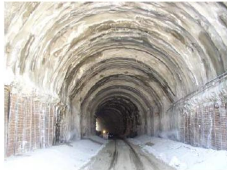
Σήραγγα μετά την πλήρη εκσκαφή
