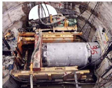
Είσοδος pipe jacking μέσω του φρέατος για την έναρξη κατασκευής
