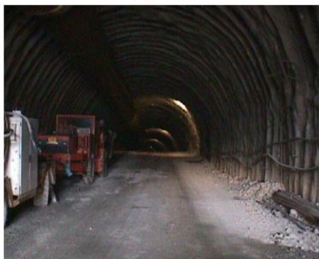
Σήραγγα κατά την σ' φάση εκσκαφής
