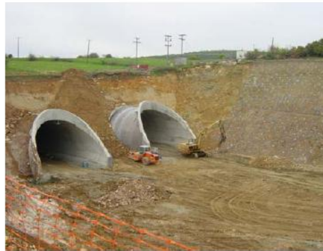
Εργασίες τελικής αποκατάστασης στομίων εισόδου
