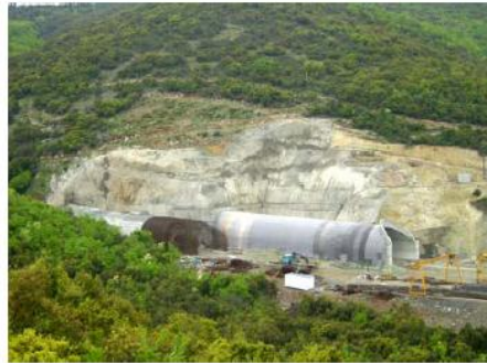
Φορέις Cut & Cover στοίμων εισόδου σήραγγας Σ1
