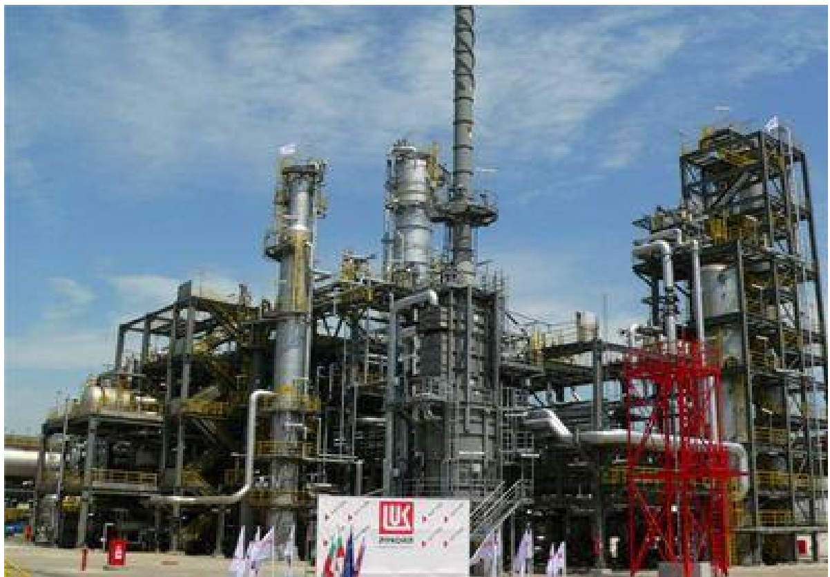
Εικόνα 2.7: Εγκαταστάσεις Διυλιστηρίου ( www.moh.gr )
