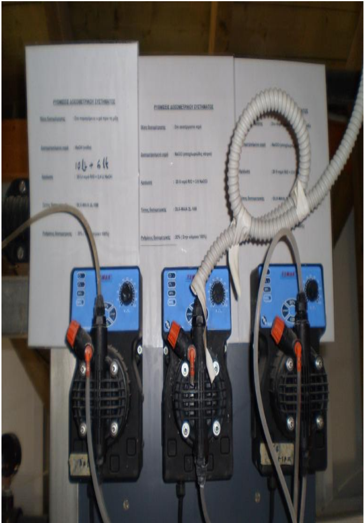
Σχήμα 6.14 : Αναπαράσταση δοσομετρητών εγκατάστασης.
