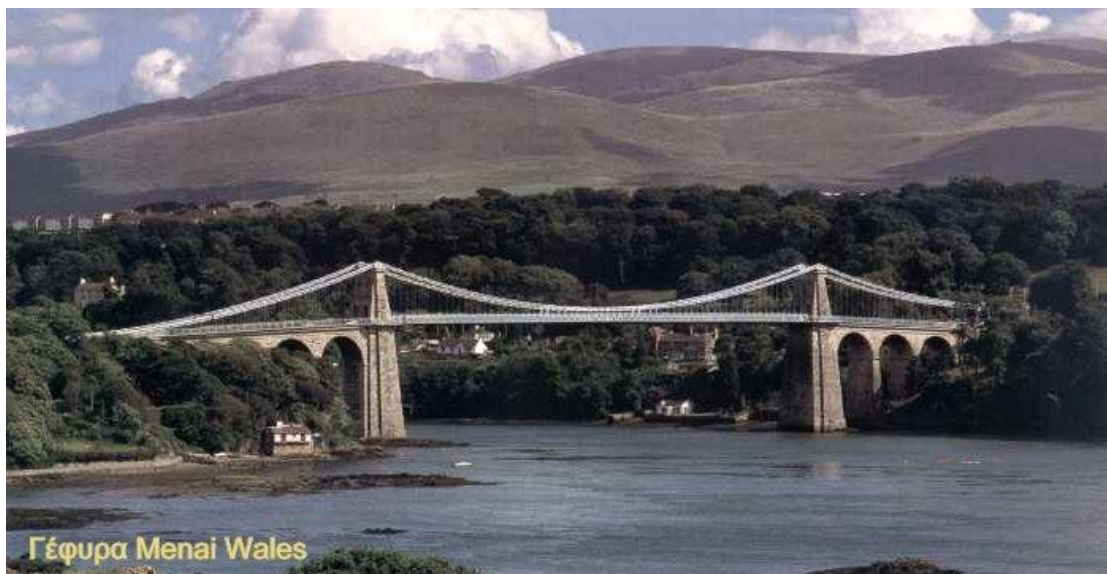
Σχήμα 4: γέφυρα Μεναί στην Ουαλία
