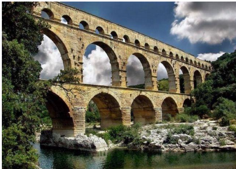
Σχήμα 3: Γέφυρα Pont du Gard
