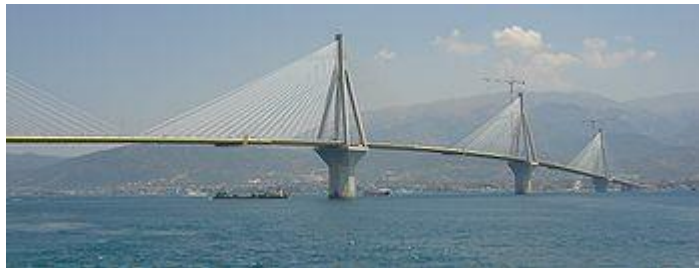
Σχήμα 7: Καλωδιωτή γέφυρα Ρίου – Αντιρίου
