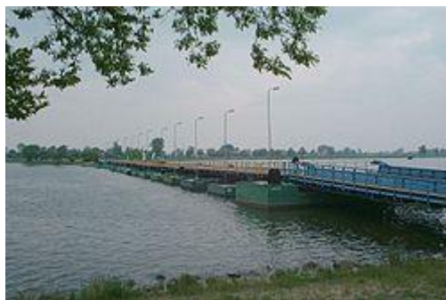
Σύγχρονη πλωτή γέφυρα
