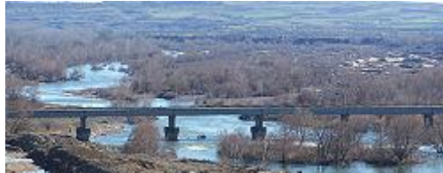
Γέφυρα σε δοκούς (ποταμός Άρδας) - οδός Κομάρων Κυπρίνου
