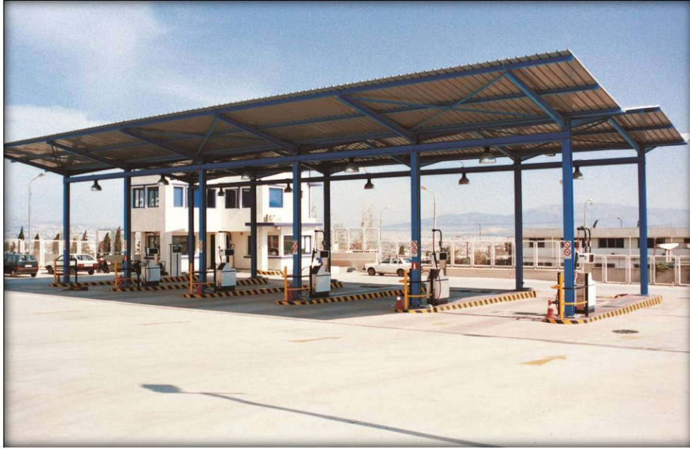
Εικ. 4.11: σταθμός ανεφοδιασμού
