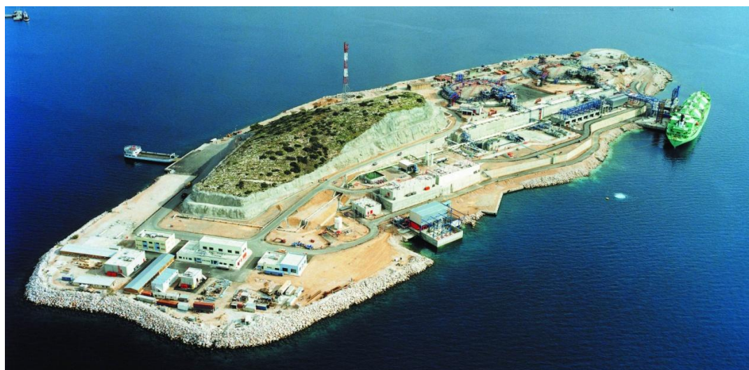
Εικ. 2.6: εγκαταστάσεις LNG νήσου Ρεβυθούσας
