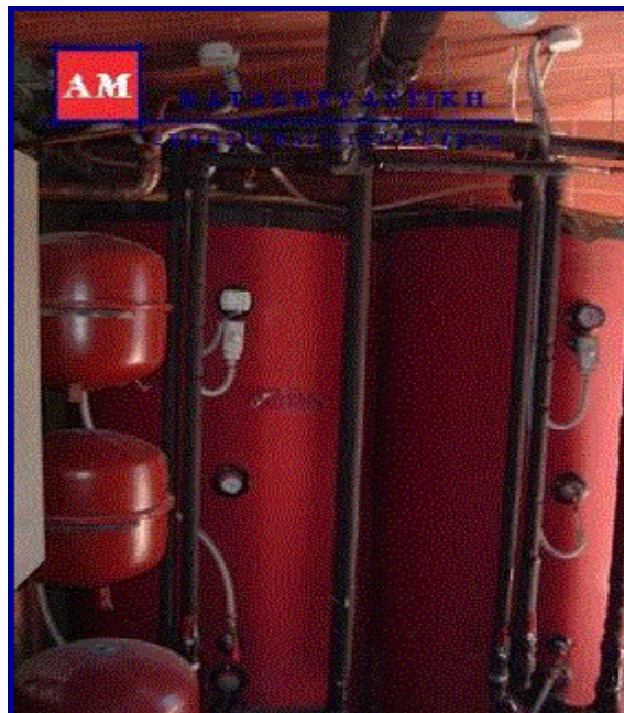
Εικόνα 7.14: Δοχεία αδρανείας για αποθήκευση θερμικής ενέργειας.
