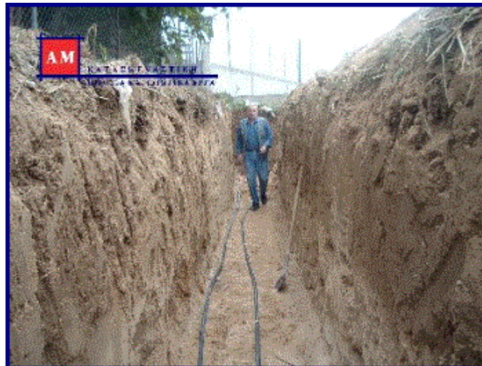
Εικόνα 7.6: Τοποθέτηση σπειρών οριζόντιου εναλλάκτη.
