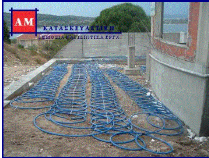
Εικόνα 7.7: Σπείρες γεωεναλλάκτη (Χαλκιδική).
