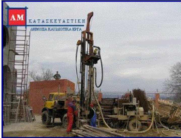
Εικόνα 7.9: Γεώτρηση κατακόρυφου εναλλάκτη (Κομοτηνή).
