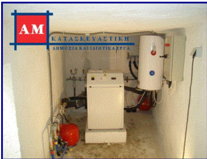
Σχήμα 3.4.3.4: Γεωθερμική Αντλία Θερμότητας (Χαλκιδική). [11]
