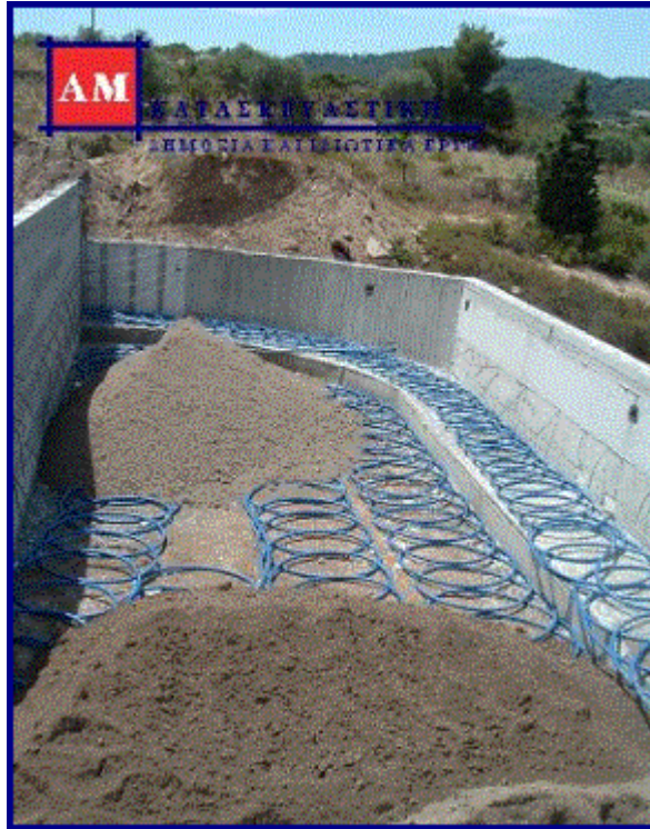
Εικόνα 7.15: Σπείρες γεωεναλλάκτη (Χαλκιδική)
