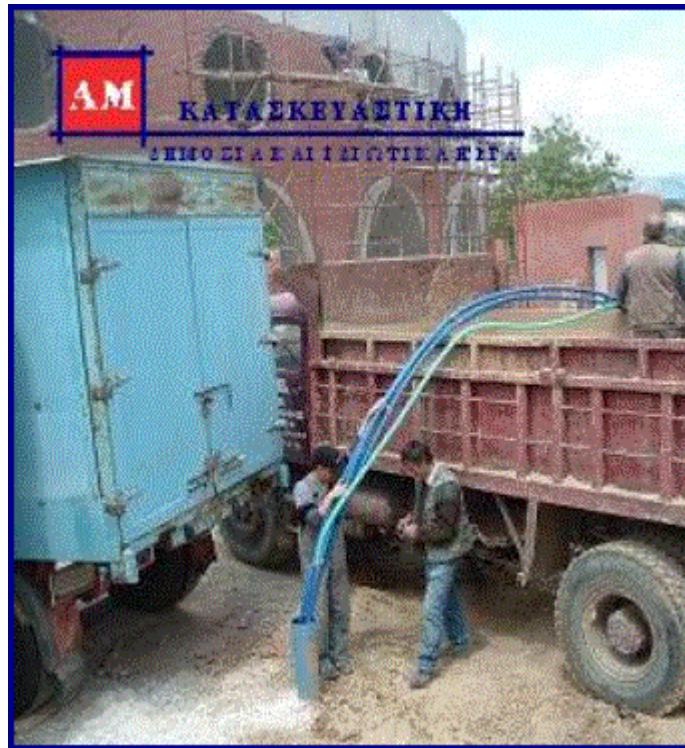
Εικόνα 7.11: Τοποθέτηση γεωεναλλάκτη στη γεώτρηση (Κομοτηνή).
