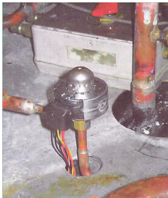
Εικόνα 3.5: Βαλβίδες εκτόνωσης
