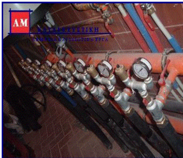
Εικόνα 7.12: Συλλέκτης κυκλώματος γης (Κομοτηνή).
