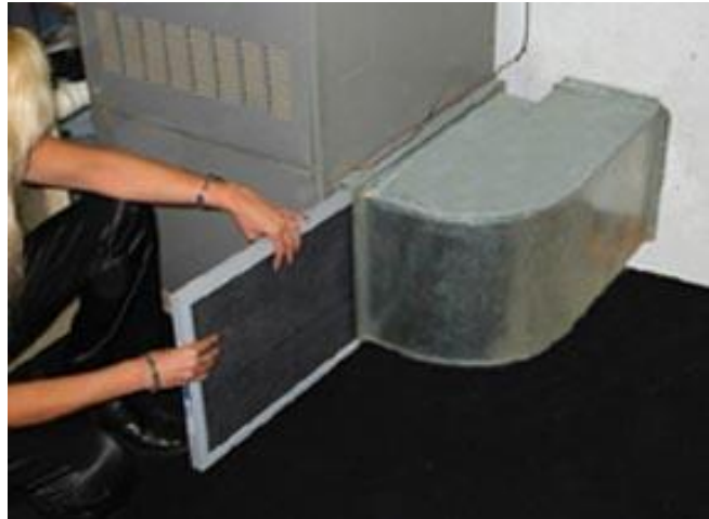
Εικόνα4.4: Τοποθέτηση ηλεκτροστατικού φίλτρου (novatrend)
