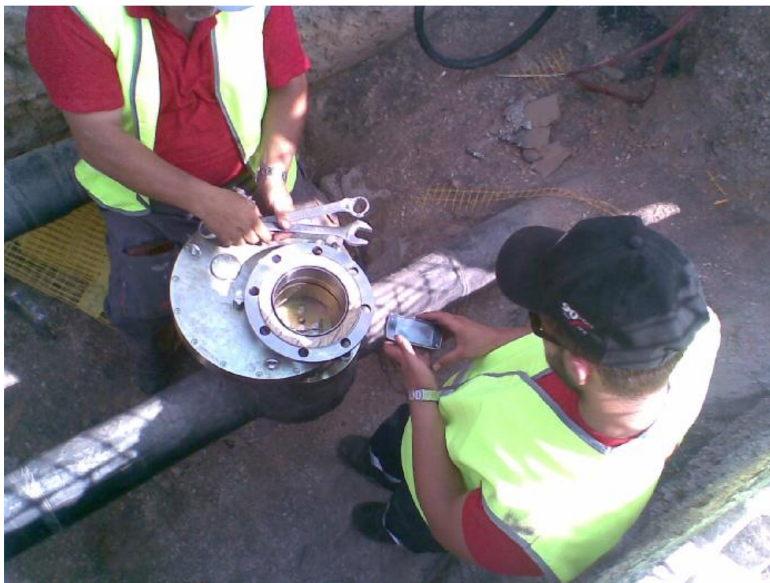
Εικόνα 18 : Βάνα με ενσωματωμένο O-ring
