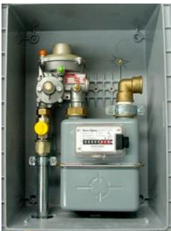
Εικόνα 13 : Οικιακός Μετρητής/Ρυθμιστής 4/0.023 bar
