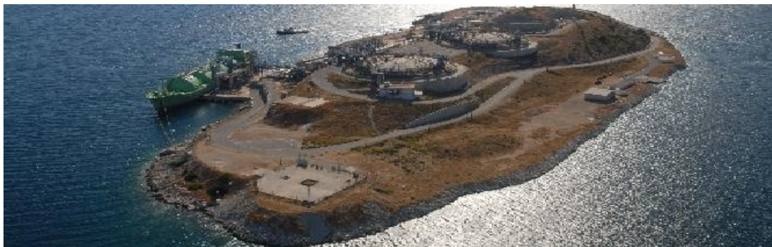
Εικόνα 3 : τερματικός σταθμός υγροποιημένου φυσικού αερίου Ρεβυθούσα
