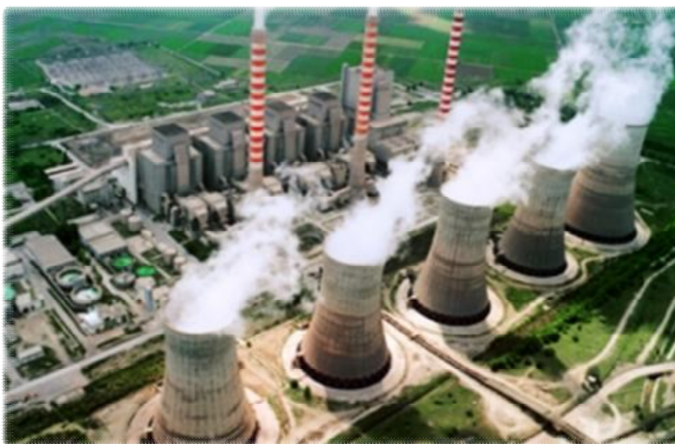
Εικόνα 6: Ατμοηλεκτρικός σταθμός Μεγαλόπολης
