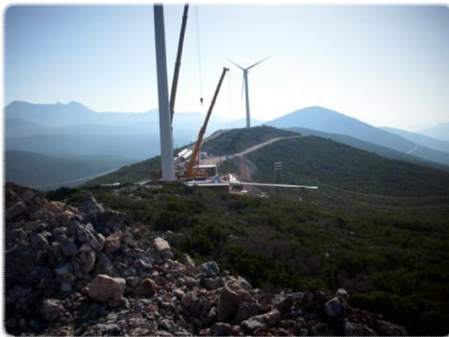
Εικόνα 15: Ανέγερση πυλώνων ανεμογεννήτριας
