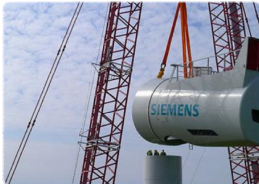
Εικόνα 16: Τοποθέτηση κυρίας ατράκτου ανεμογεννήτριας
