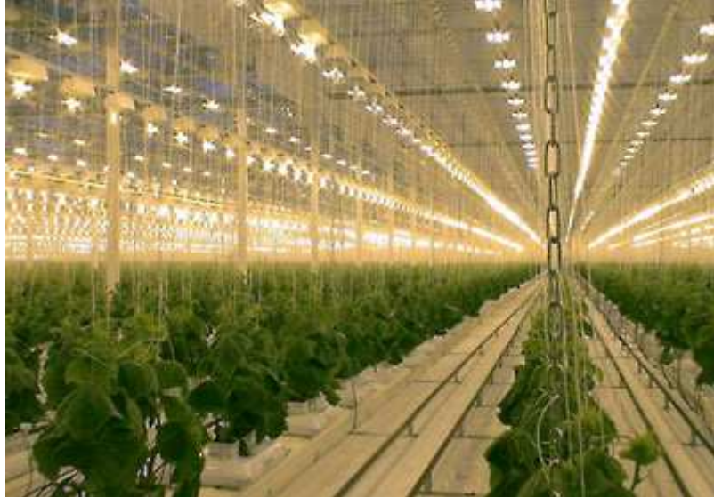
Εικόνα 5.2 : Τεχνητός φωτισμός θερμοκηπίου με λαμπτήρες (Μαυρογιαννόπουλος Γ., 2005)
