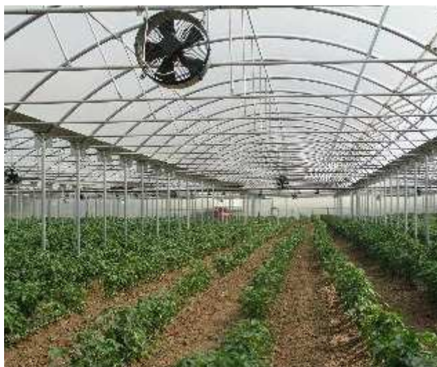
Εικόνα 5.4 : Δυναμικός εξαερισμός θερμοκηπίου με χρήση ανεμιστήρων (Μαυρογιαννόπουλος Γ., 2005)
