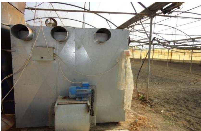
Εικόνα 3.6 : Αερολέβητας πετρελαίου Radialand AE 300
