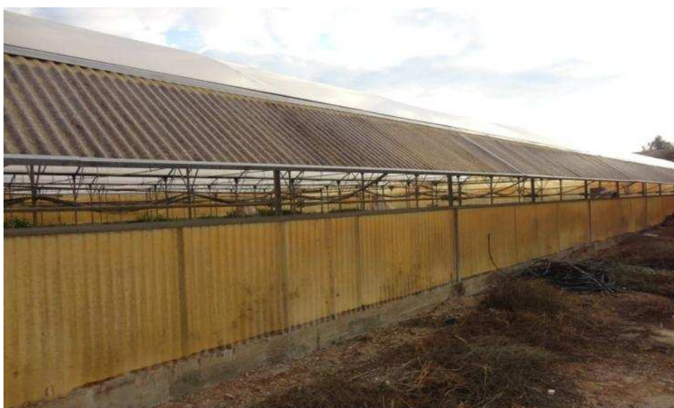
Εικόνα 5.5 : Πλαϊνά παράθυρα θερμοκηπίου μελέτης
