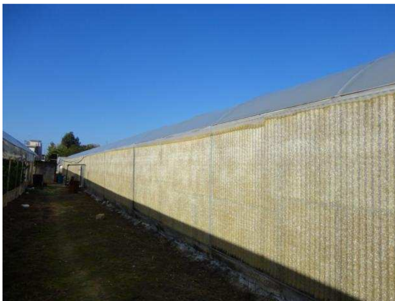
Εικόνα 3.2 : Πλάγια όψη θερμοκηπίου
