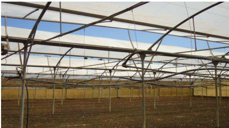
Εικόνα 5.3 : Ανοίγματα θερμοκηπίου μελέτης με παράθυρα οροφής
