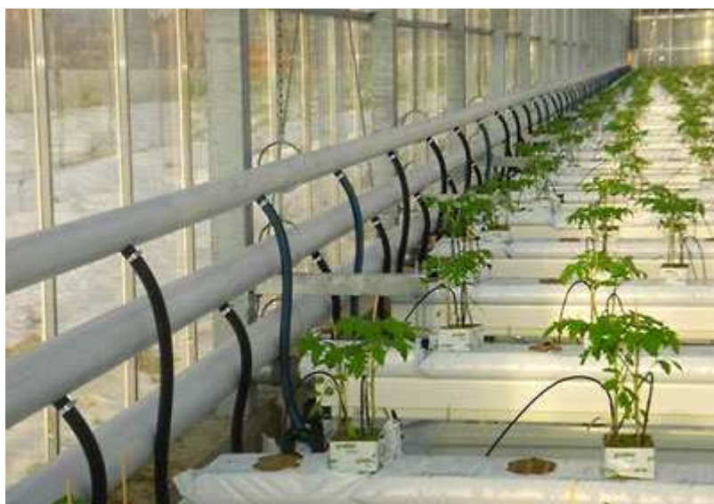
Εικόνα 5.1 : Σύστημα θέρμανσης θερμοκηπίου θερμού νερού με σωληνώσεις (Μαυρογιαννόπουλος 2001)
