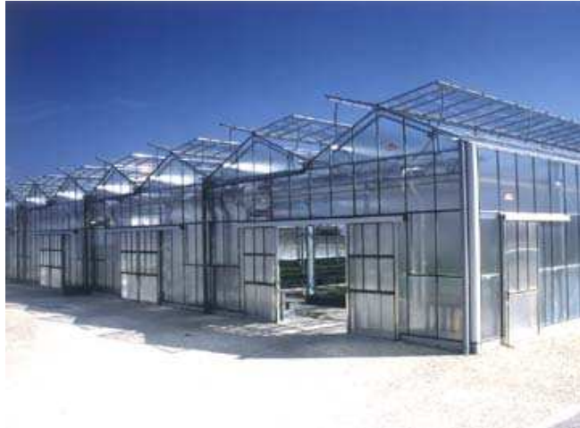
Εικόνα 1.9 : Θερμοκήπιο με ανοίγματα οροφής και πλαϊνά ( www.agroengineering.org )
