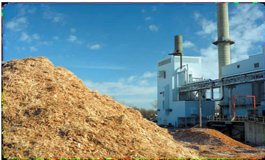
Εικόνα 2.7 : Εγκαταστάσεις συλλογής βιομάζας για παραγωγή ηλεκτρικής Ενέργειας ( www.usasolarwind.com )
