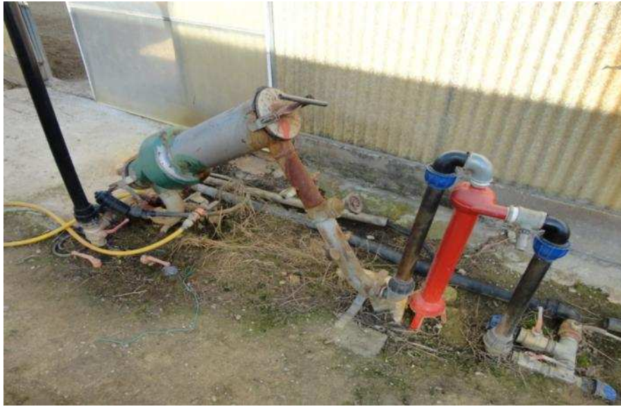
Εικόνα 3.11 : Φίλτρο καθαρισμού του νερού πριν το πότισμα
