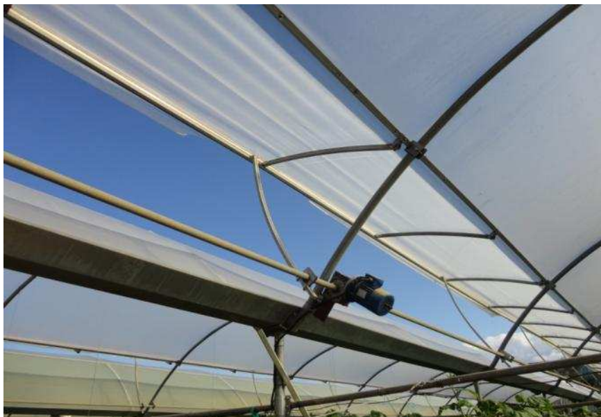
Εικόνα 3.14 : Παράθυρα οροφής θερμοκηπίου
