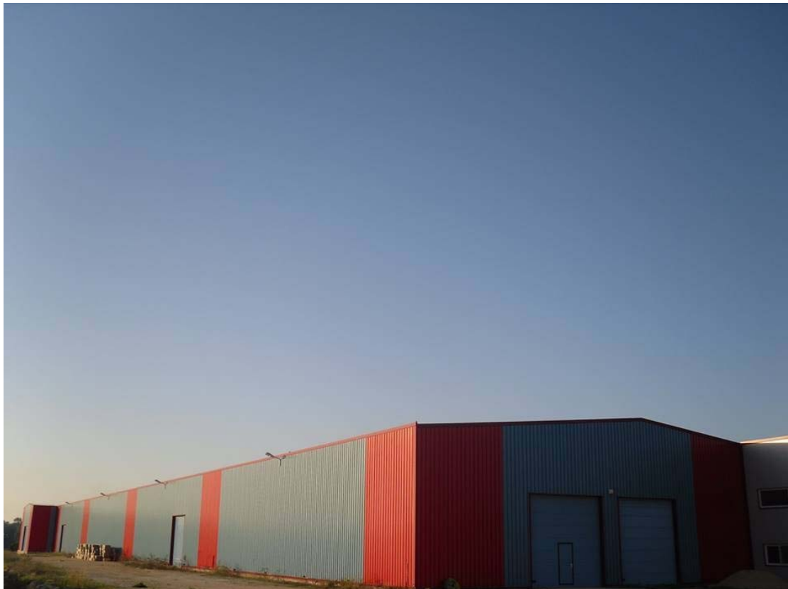
Σχήμα 5.2 Το μεταλλικό κτίριο στο οποίο στεγάζεται η εταιρεία Γ. Λιαρομάτης & ΣΙΑ Ο.Ε.
