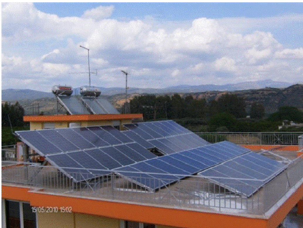
Σχήμα 2.24. Σύστημα εγκατεστημένο σε επίπεδη στέγη
