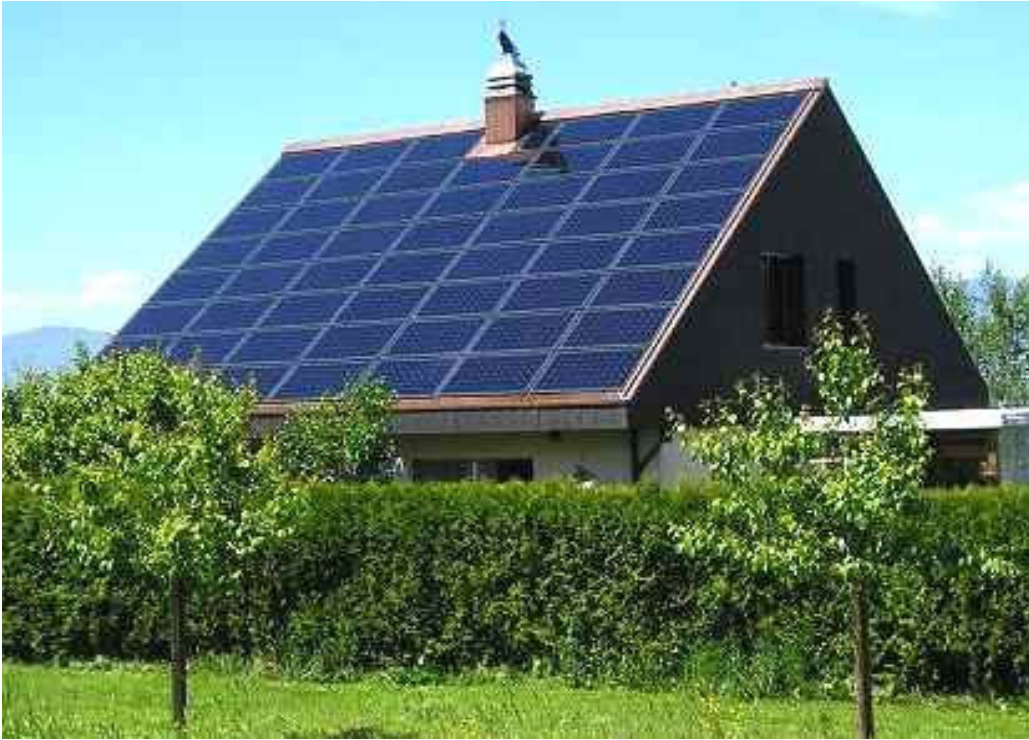
Σχήμα 2.25. Σύστημα εγκατεστημένο σε επικλινή στέγη
