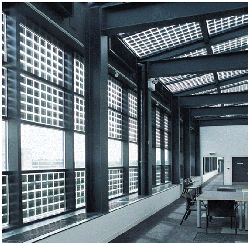
Σχήμα 2.26. Συστήματα ενσωματωμένα στο κέλυφος κτιρίου (BIPV)
