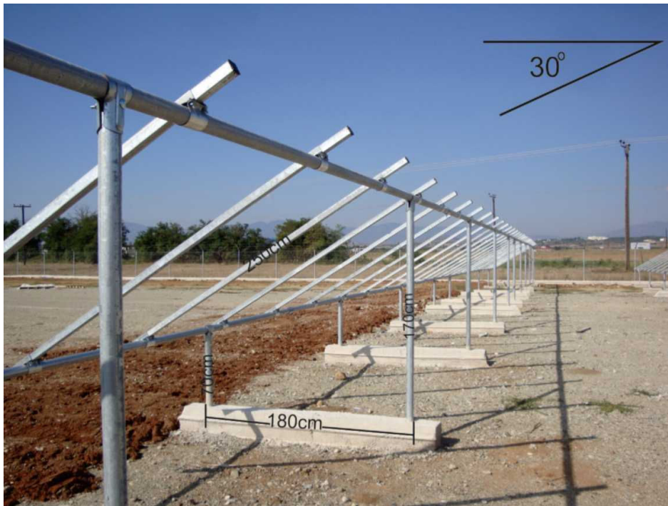
Σχήμα 5.14. Βάση σκυροδέματος με στρογγυλά προφίλ
