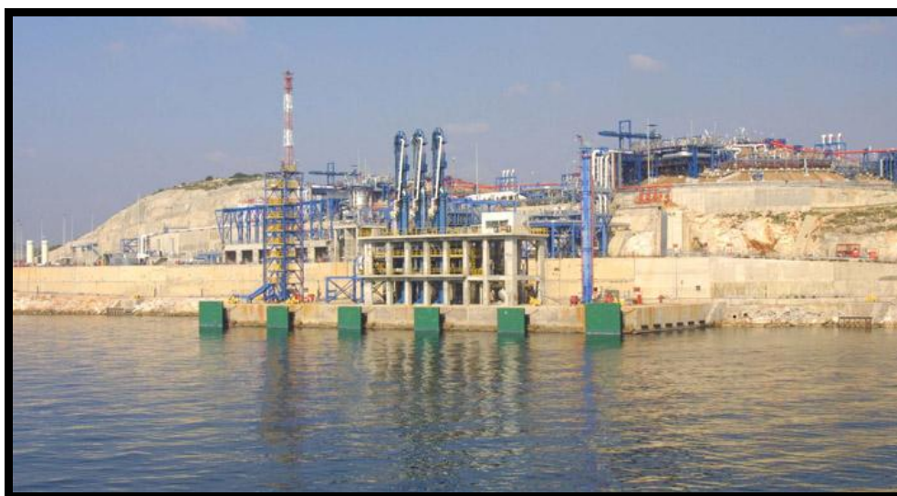
Εικόνα 2.5 Σταθμός υγροποιημένου Φυσικού Αερίου.
