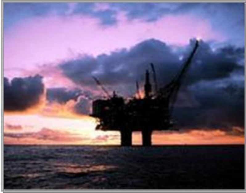
Εικόνα 2.1 Γεώτρηση Φυσικού Αερίου.
