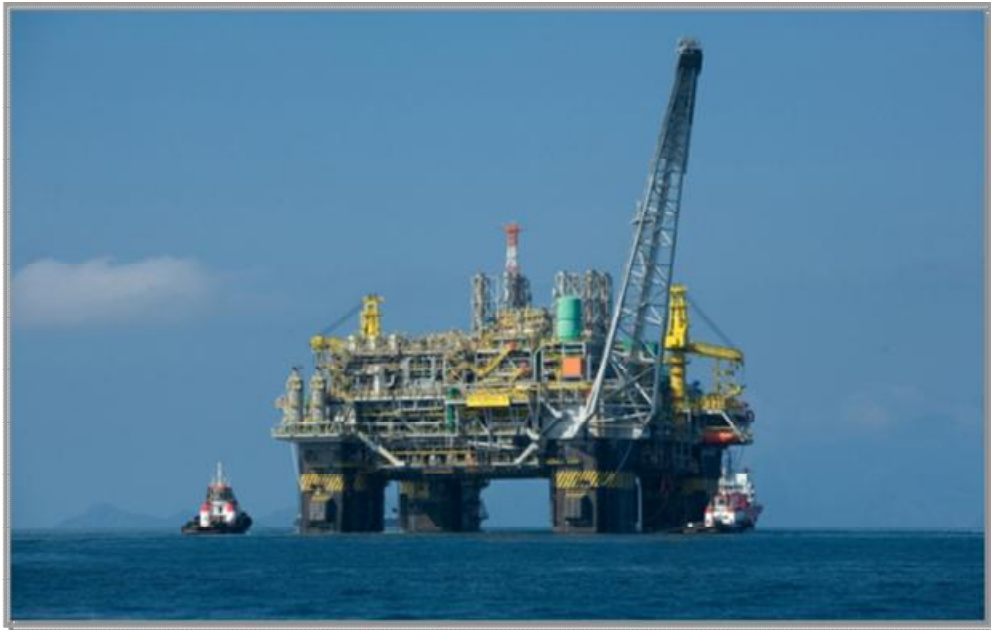
Εικόνα 2.2 Γεώτρηση Φυσικού Αερίου.
