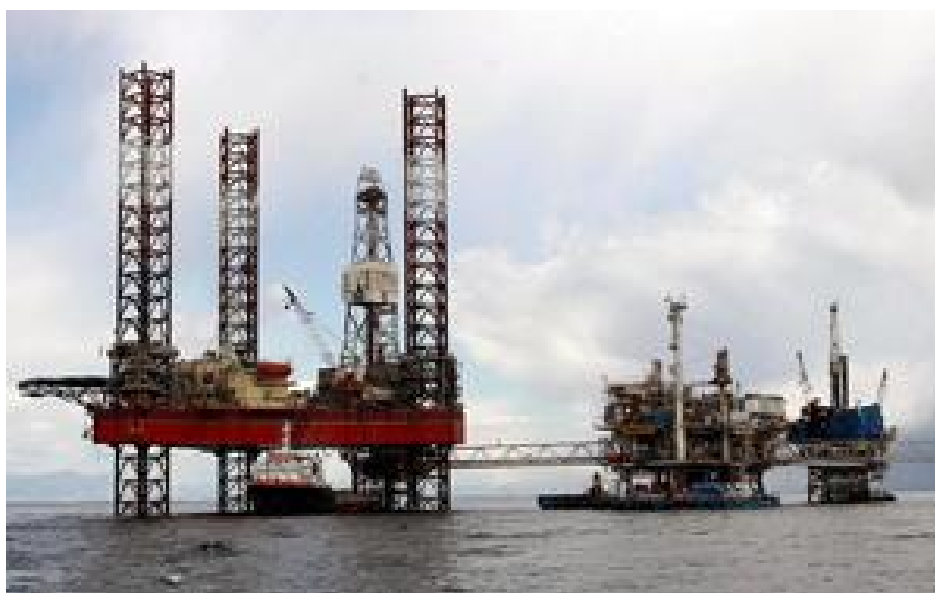
Εικόνα 3.5 Γεώτρηση Φυσικού Αερίου.
