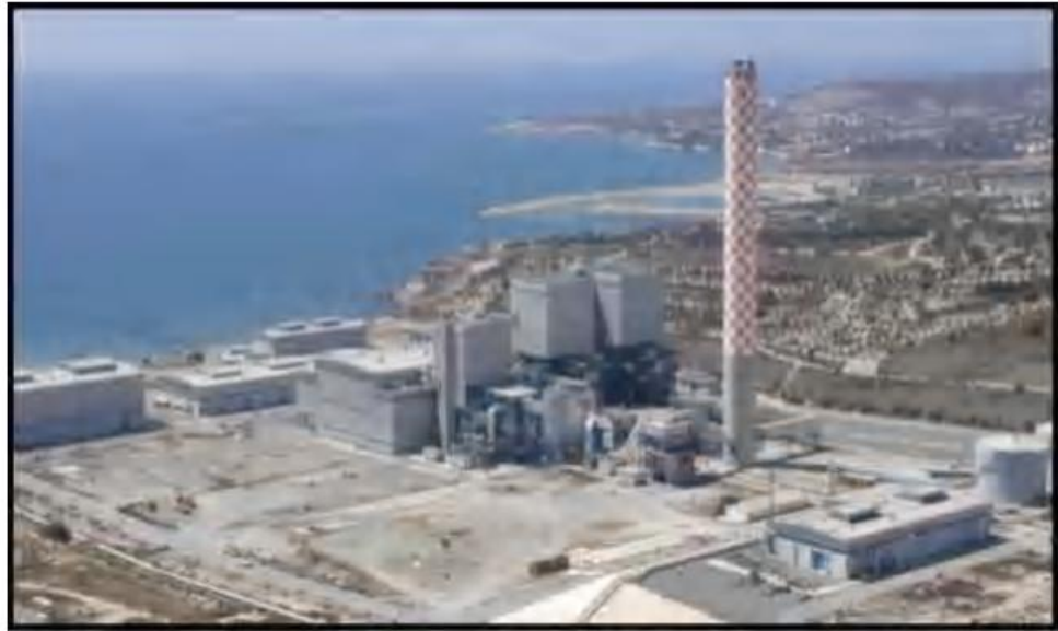
Εικόνα 5.1 Ηλεκτροπαραγωγικός Σταθμός Βασιλικού.
