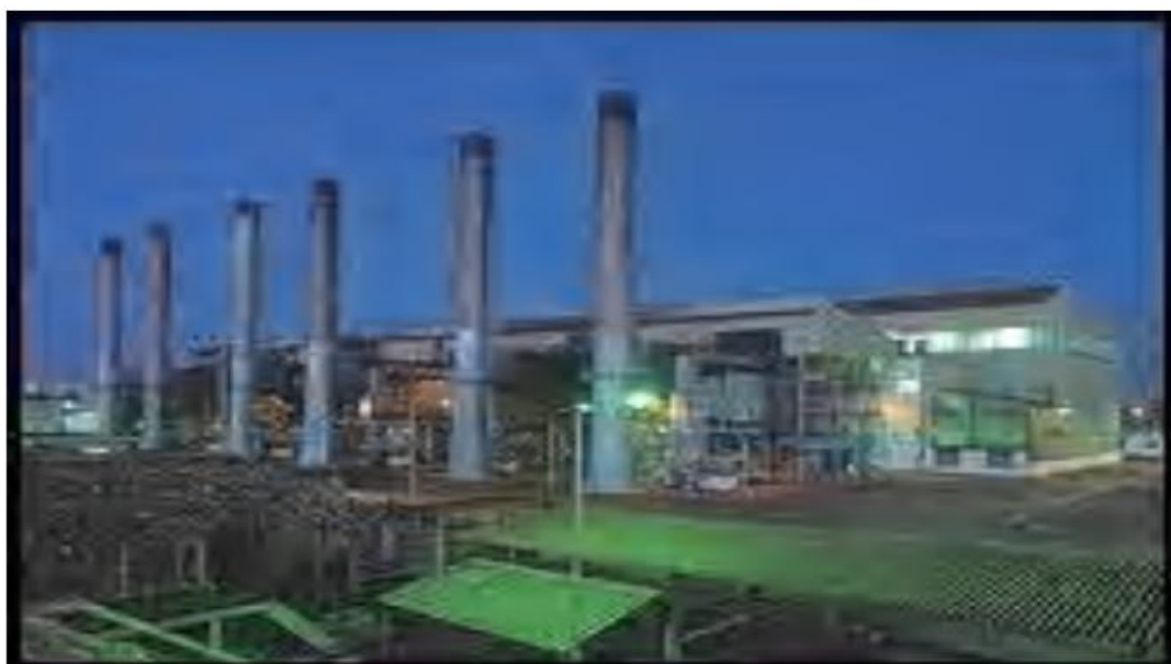
Εικόνα 5.2 Ηλεκτροπαραγωγικός σταθμός Μονής.
