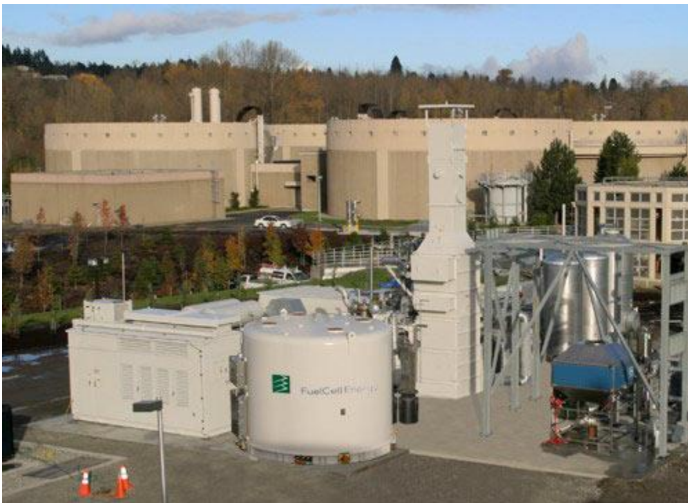
Σχήμα 1.17: Εικόνα της 100-MWh εγκατάστασης αποθήκευσης ηλεκτρικής ενέργειας που είναι εγκατεστημένη στο Cambridgeshire, στην Αγγλία. Οι δεξαμενές αποθήκευσης για τα διαλύματα ηλεκτρολύτη («καύσιμο») μπορεί να γίνει ορατή καθαρά.
