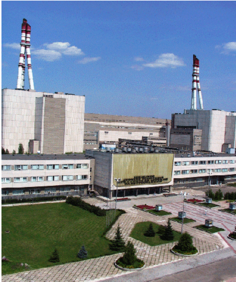
Εικόνα 3.6 Ο αντιδραστήρας RBMK Ignalina στη Λιθουανία δυναμικότητας 1300MW ηλεκτρικής ισχύος (έκλεισε το 2009) [7].
