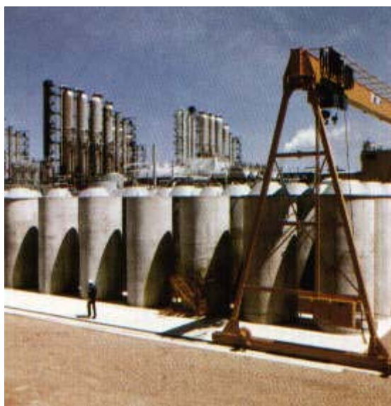
Εικόνα 6.2.: Δοχεία ξηράς αποθήκευσης συστάδων καυσίμου.
