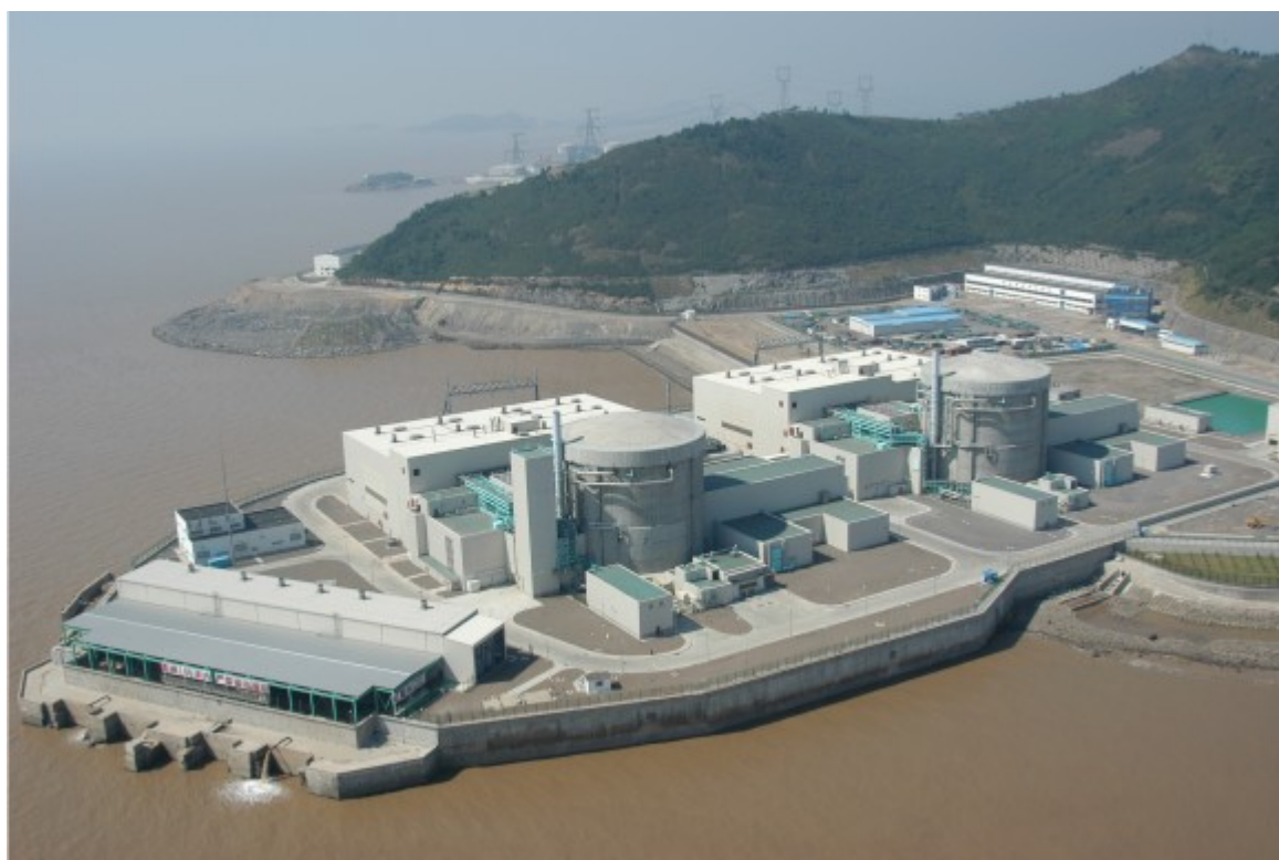
Εικόνα 3.4 Ο πυρηνικός σταθμός Qinshan στην Κίνα περιλαμβάνει δύο αντιδραστήρες τύπου CANDU 728MW [7].
