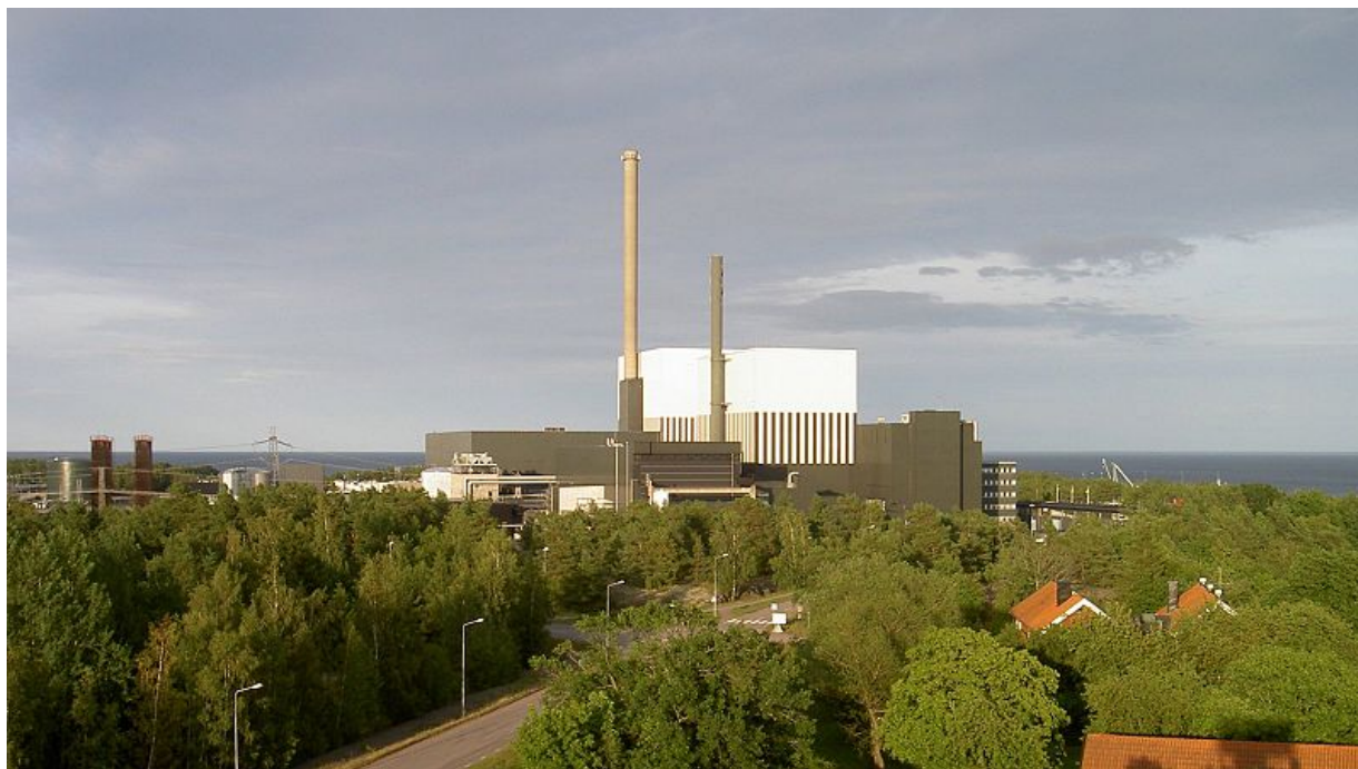
Εικόνα 3.3 Ο πυρηνικός σταθμός Oskarshamn στη Σουηδία που χρησιμοποιεί τεχνολογία BWR [7].
