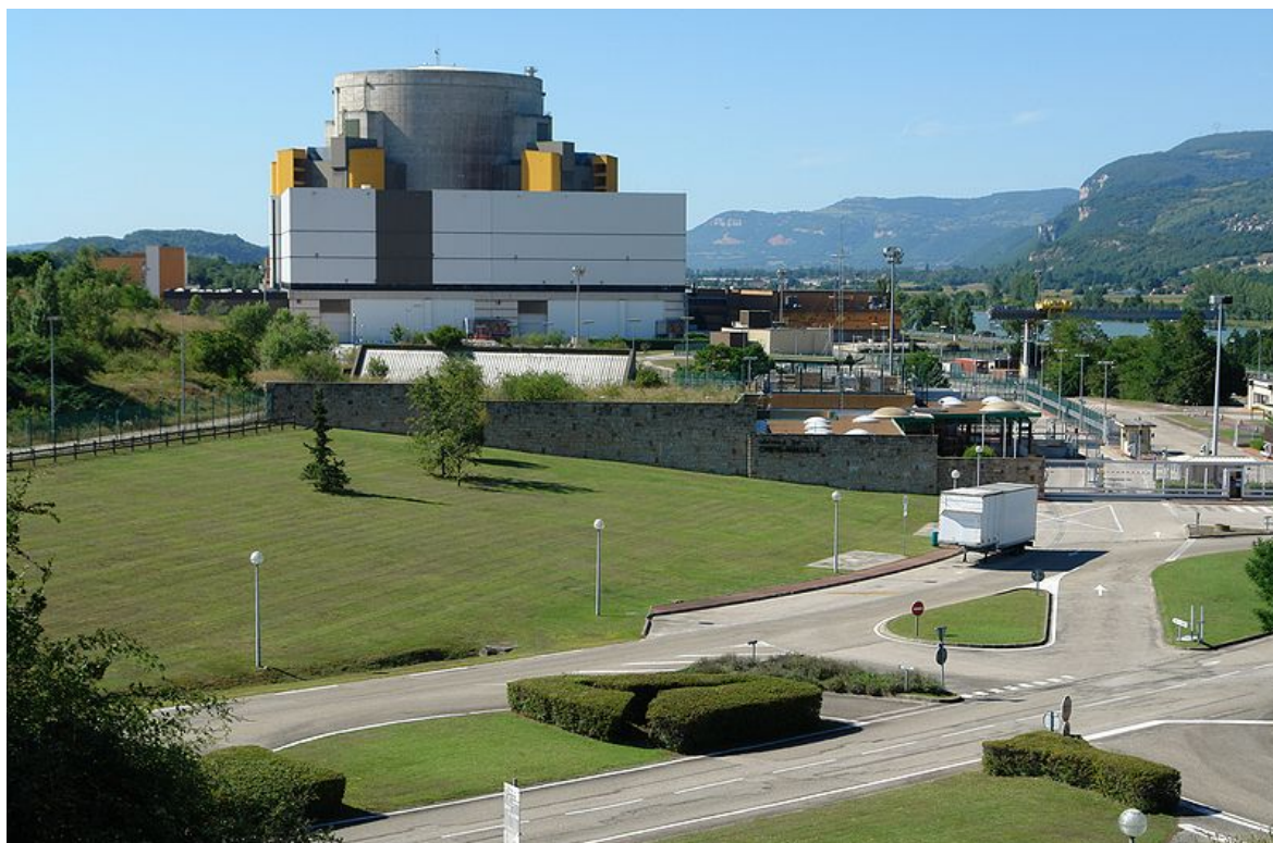
Εικόνα 3.10 Ο αντιδραστήρας Superphenix στη Γαλλία. Ο μεγαλύτερος αντιδραστήρας τύπου FBR στον κόσμο με παραγόμενη ηλεκτρική ισχύ 1200MW [7].
