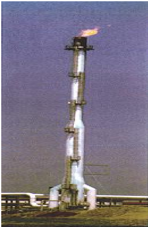
Εικόνα 28: Άκαπνη καπνοδόχος με υποβοήθηση αέρα με δύο φυσητήρες στο διυλιστήριο.
