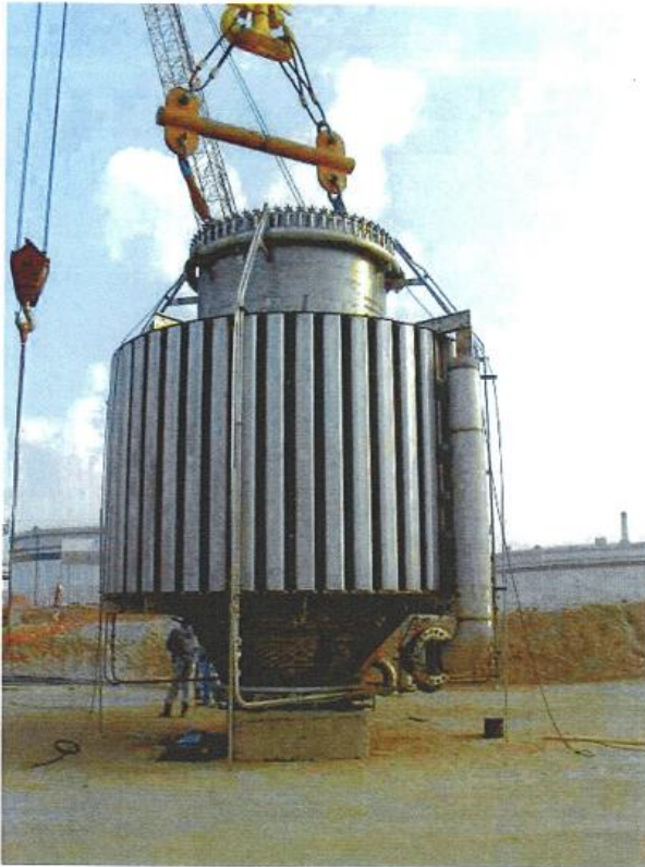
Εικόνα 27: Υψηλής τεχνολογίας καυστήρας καπνοδόχου και σιλανσιέ.
