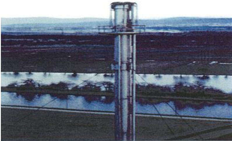
Εικόνα 23: Απλή καπνοδόχος με υποβοήθηση ατμού.
