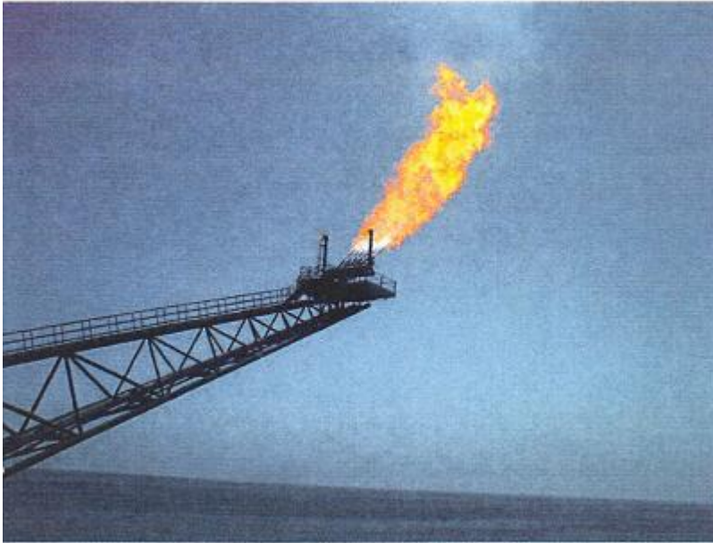
Εικόνα 36: Καπνοδόχος με υποβοήθηση νερού.
