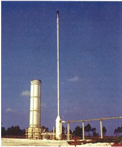
Εικόνα 9: Συνδυασμένο σύστημα καπνοδόχου.
