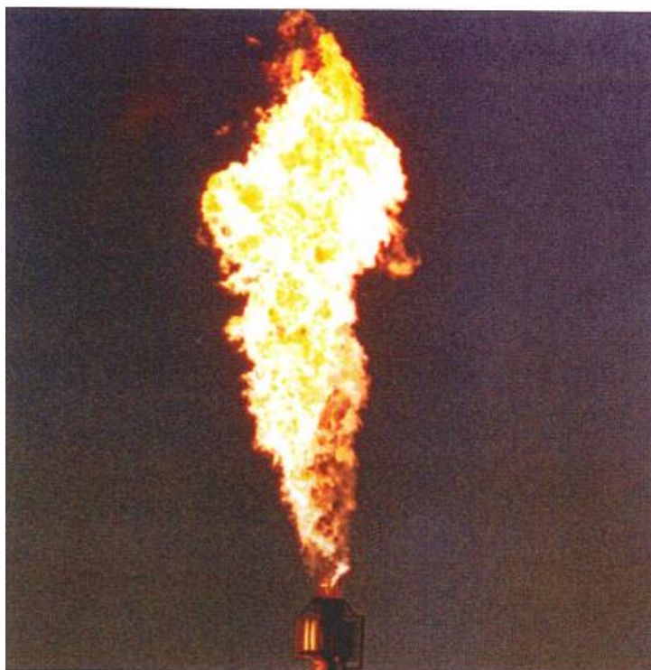
Εικόνα 20: Καπνοδόχος χωρίς καπνό με υποβοήθηση ατμού.
