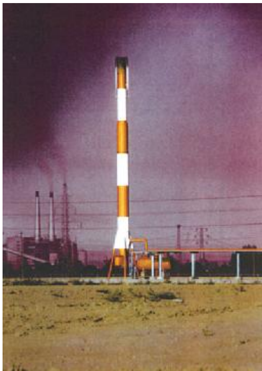
Εικόνα 42: Οριζόντια τοποθετημένο τύμπανο στη βάση μιας με αέρα υποβοηθούμενης καπνοδόχου.
