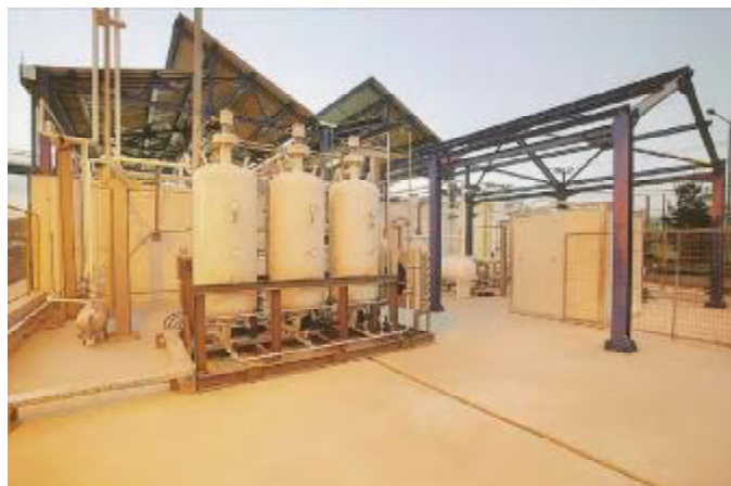
Εικόνα 4.22: Αφυγραντές φυσικού αερίου
