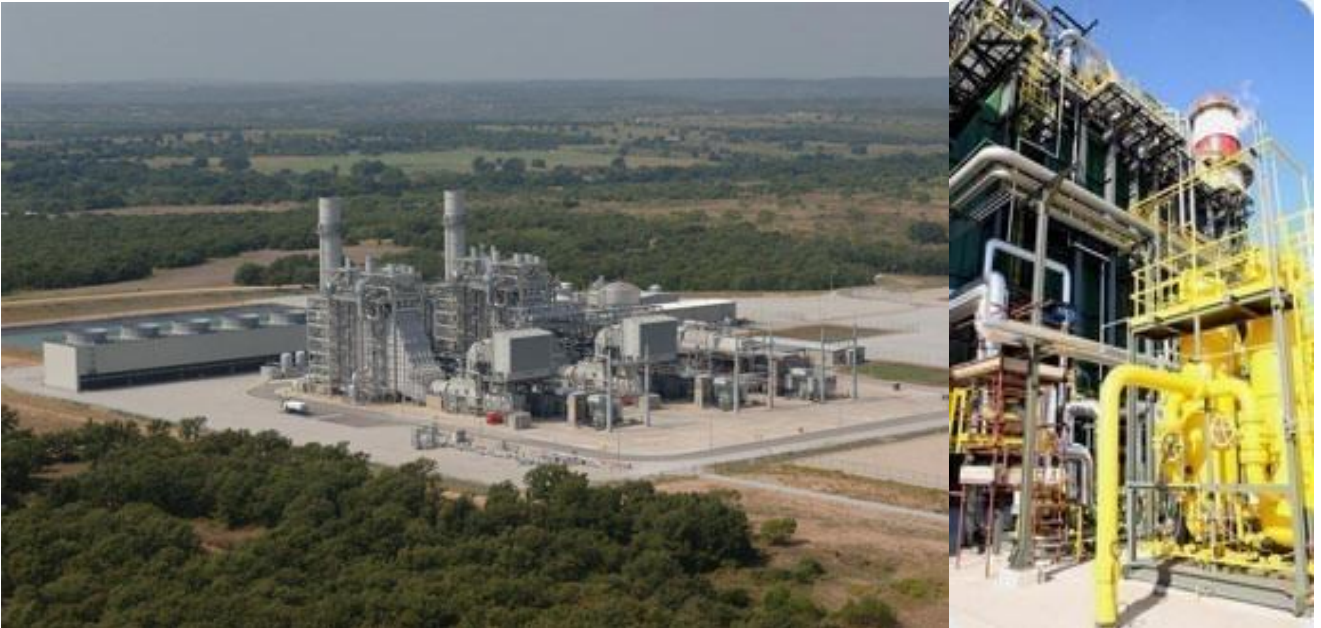
Εγκατάσταση ηλεκτροπαραγωγής φυσικού αερίου με τεχνολογία συνδυασμένου κύκλου
