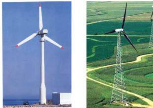
Εικόνα 24 : Α/Γ με σωληνωτό χαλύβδινο πύργο (αριστερά) και δικτυωτό πύργο (δεξιά)
