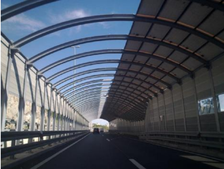
Σχήμα 2.12: Ηχώφραγμα σε αυτοκινητόδρομο στην Rijeka της Κροατίας, όπου έχει στην οροφή του φωτοβολταϊκά στοιχεία [Wikipedia.org]
