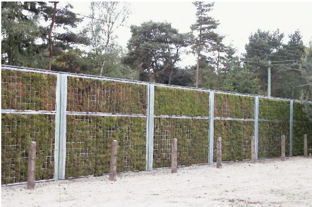
Σχήμα 2.15: Απορροφητικού τύπου ηχοφραγμα αποτελούμενο από φυτά [Wikipedia.org]
