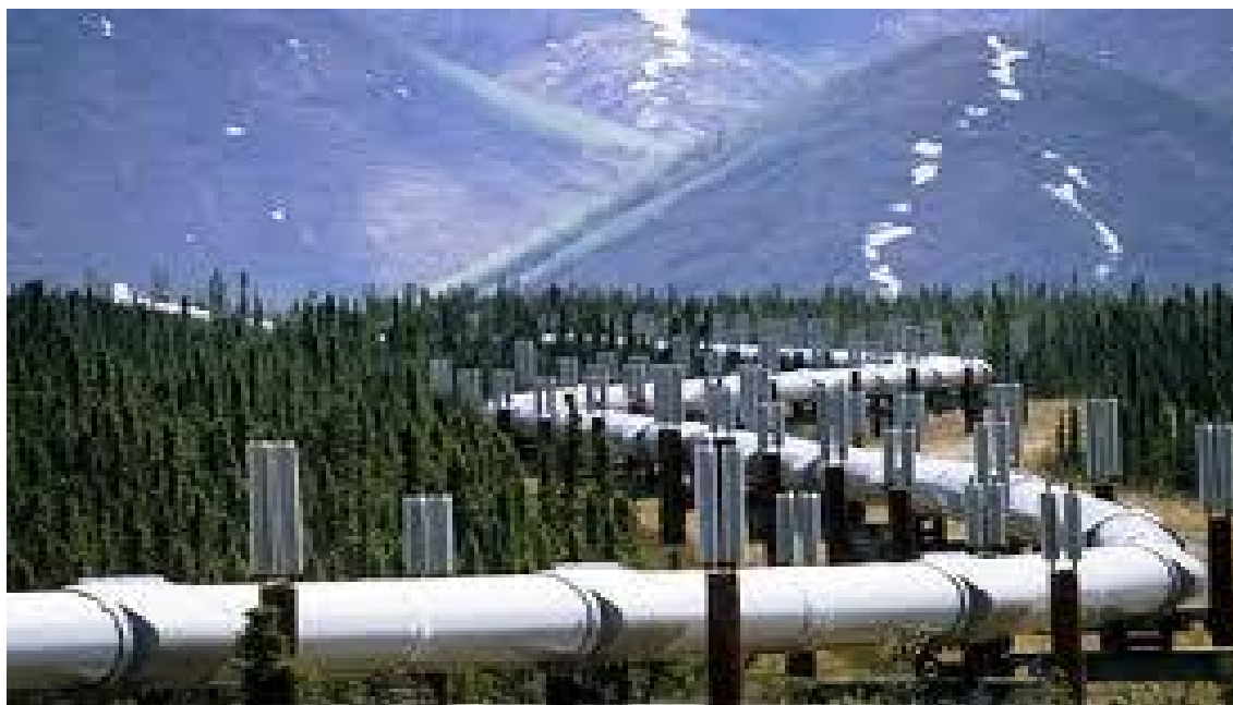
ΕΙΚΟΝΑ 4.Ο Αγωγός South Stream.
