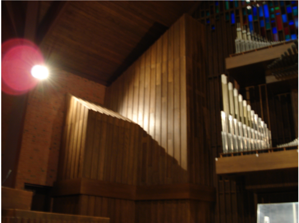
Εικόνα 2.11: Οι γρίλιες του swell division σε κλειστή θέση
