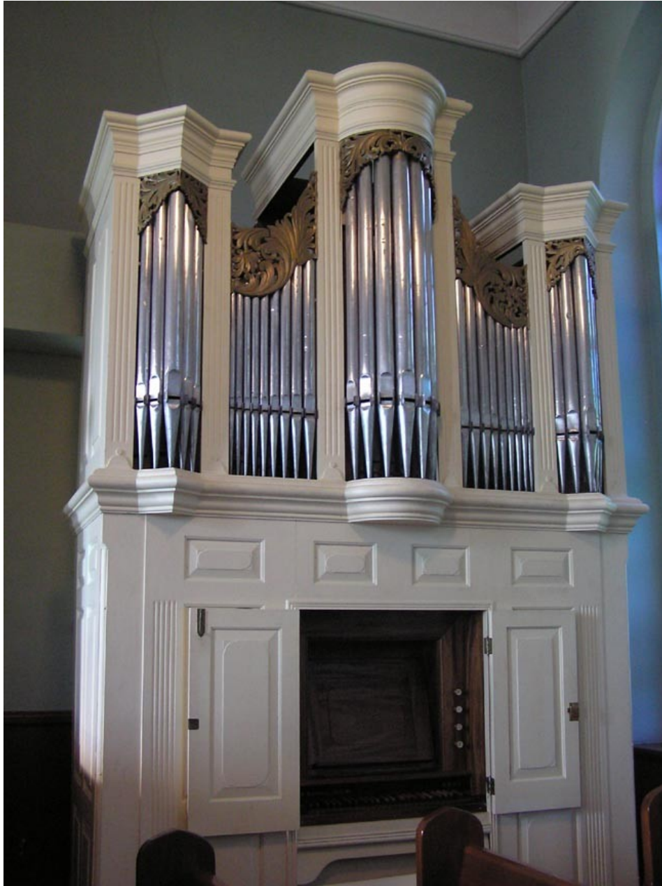
Εικόνα 2.35: Μεταλλικοί χειλεόφωνοι αυλοί στην πρόσοψη του οργάνου με μεγαλύτερη αναλογία κασσίτερου
