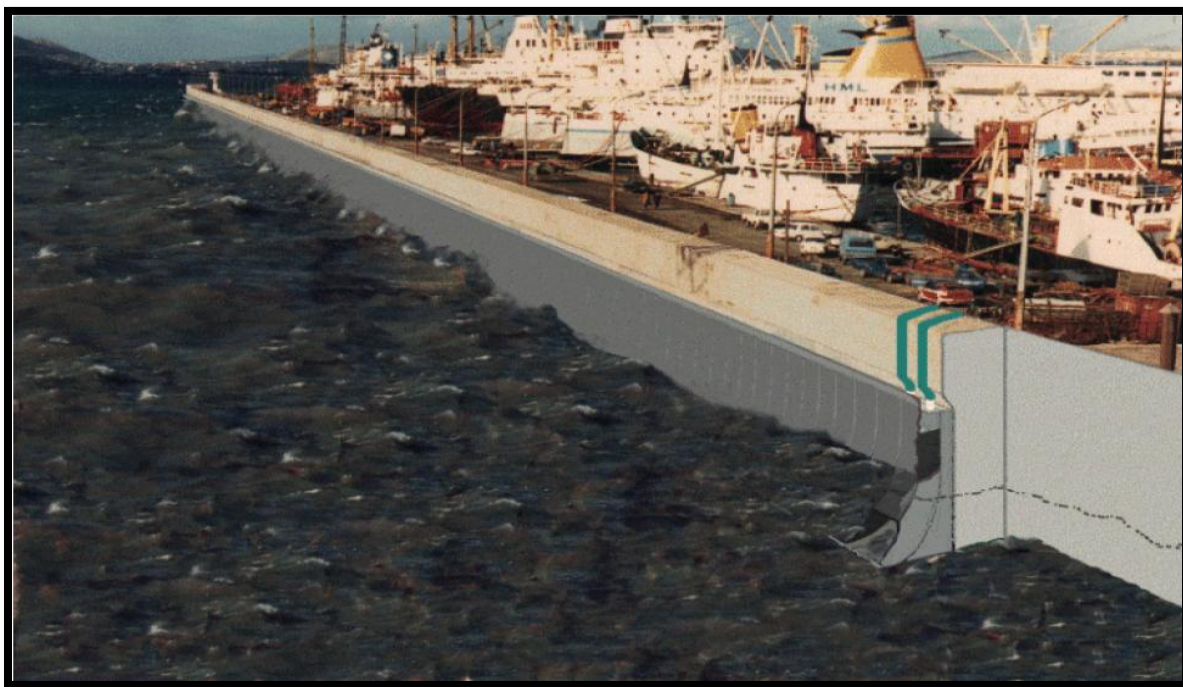
Εικόνα 6: Συσκευή WECA σε κυματοθραύστη
