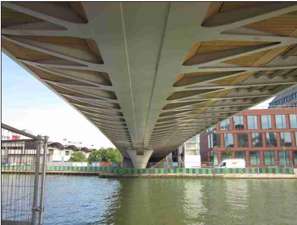
Εικόνα 1.11: Γέφυρα συνεχούς δοκού
