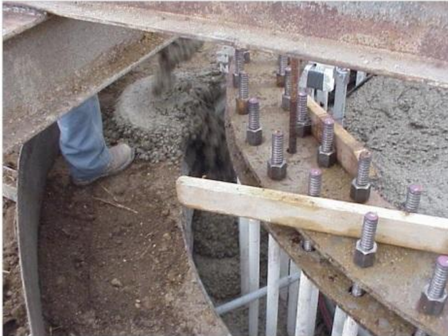
Φωτογραφία 7.13α: Σκυρόδεση της Βάσης
