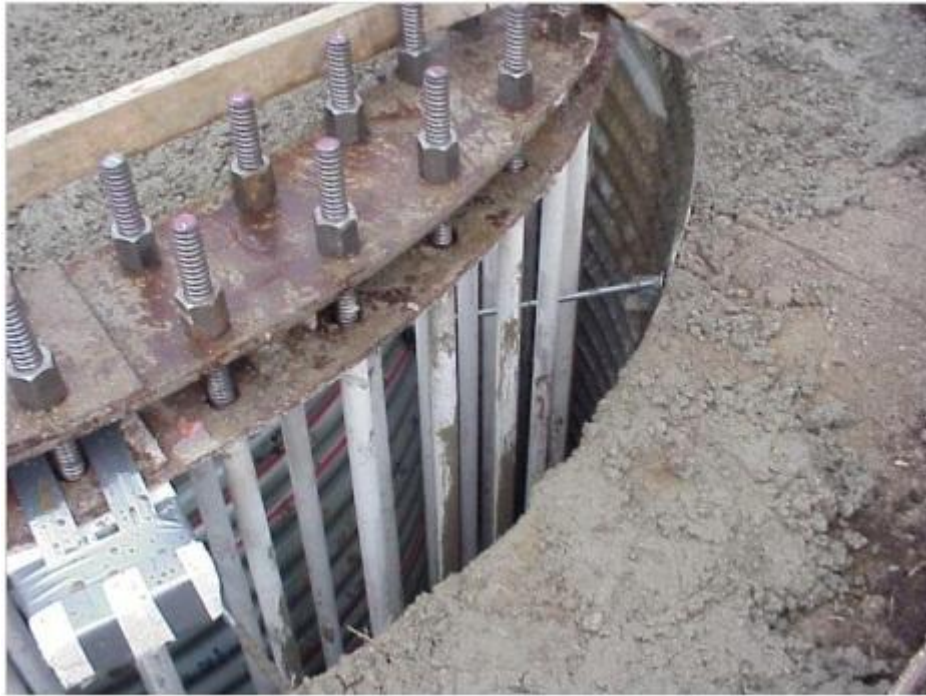
Φωτογραφία 7.13β: Οι κοχλίες με τις ράβδους μετά την σκυρόδεση.
