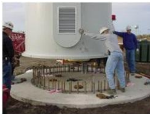
Εικόνα 7.12.α: Α/Γ από Αιολικό πάρκο. Εικόνα 4.12.β: Τοποθέτηση του πύργου της Α/Γ σε βάση σκυροδέματος
