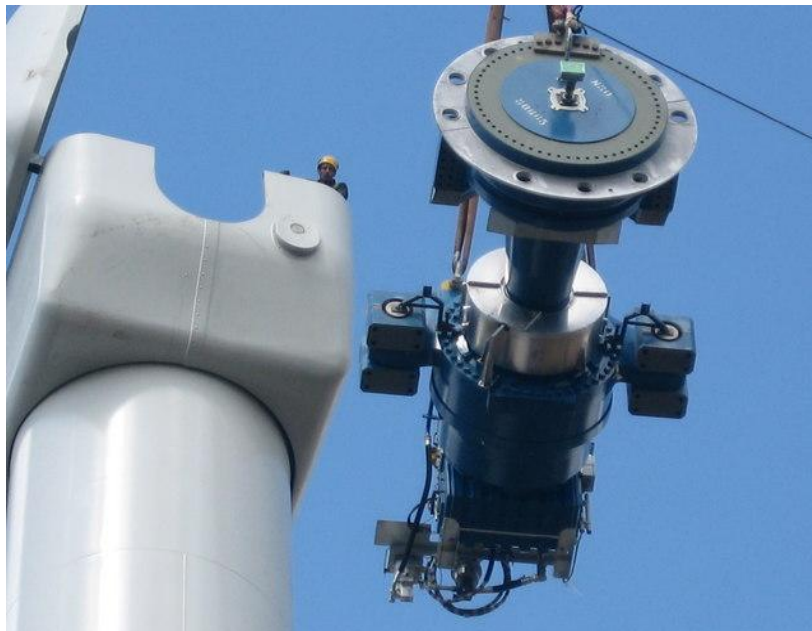
Εικόνα 2.9: Κιβώτιο ταχυτήτων ανεμογεννήτριας
