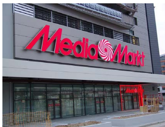
Εικόνα 1.3: Φωτεινή επιγραφή με γράμματα φανερού φωτισμού και όψη από πολυμερές (plexiglas)
