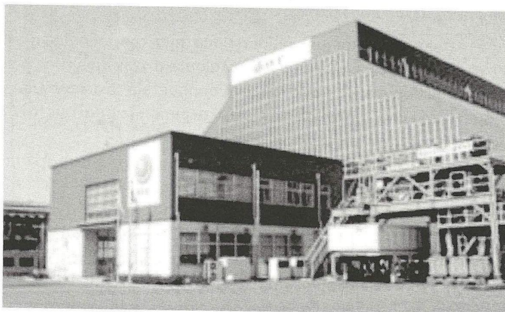
Σχήμα 5.6 Το εργοστάσιο αεριοποίησης στην πόλη Chiba της Ιαπωνίας που βασίζεται στη διεργασία Thermoselect [2].
