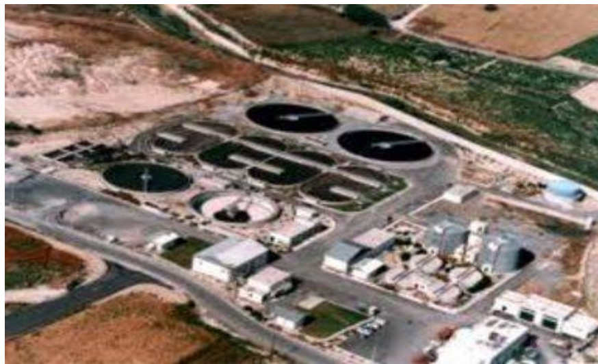
Εικόνα 1: Βιολογικός Καθαρισμός της πόλης του Ηρακλείου
