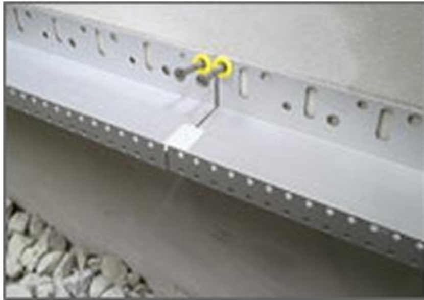
Σχήμα 7.4: Τοποθέτηση οδηγών έναρξης.
