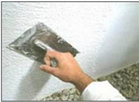
Σχήμα 7.11: Τοποθέτηση τελικού διακοσμητικού σοβά.
