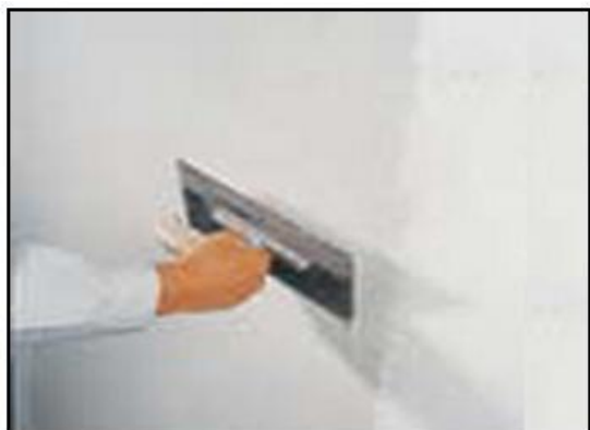
Σχήμα 7.10: Τοποθέτηση ενισχυτικού σοβά.
