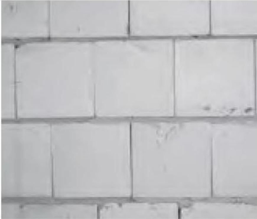
Σχήμα 7.3: Υπόστρωμα ικανό να φέρει φορτία και κατάλληλο για συγκόλληση, με ανεπιπεδότητες έως 1cm/m.
