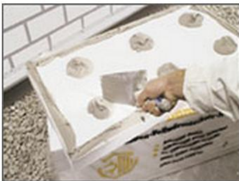
Σχήμα 7.5: Τοποθέτηση θερμομονωτικών πλακών.
