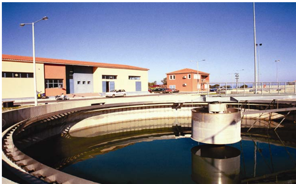
Εικόνα 3.14. Δεξαμενή καθίζησης ( www.google.gr/images )
