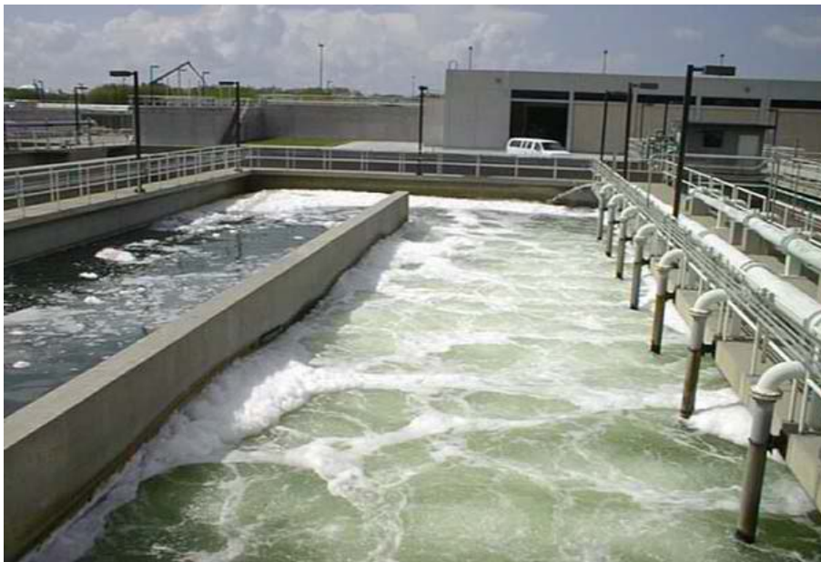
Εικόνα 3.19. Δεξαμενή χλωρίωσης. ( www.google.gr/images )
