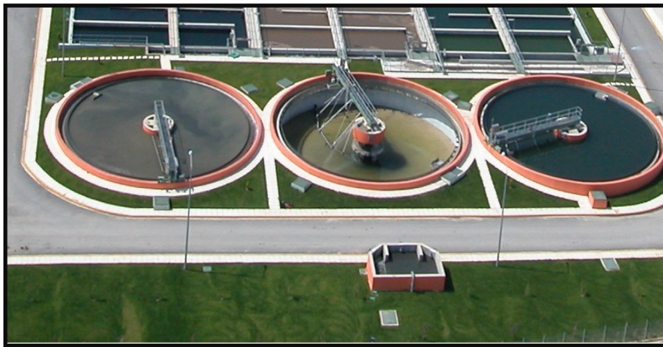
Εικόνα 3.12. Μονάδα πρωτοβάθμιας καθίζησης ( www.google.gr/images )
