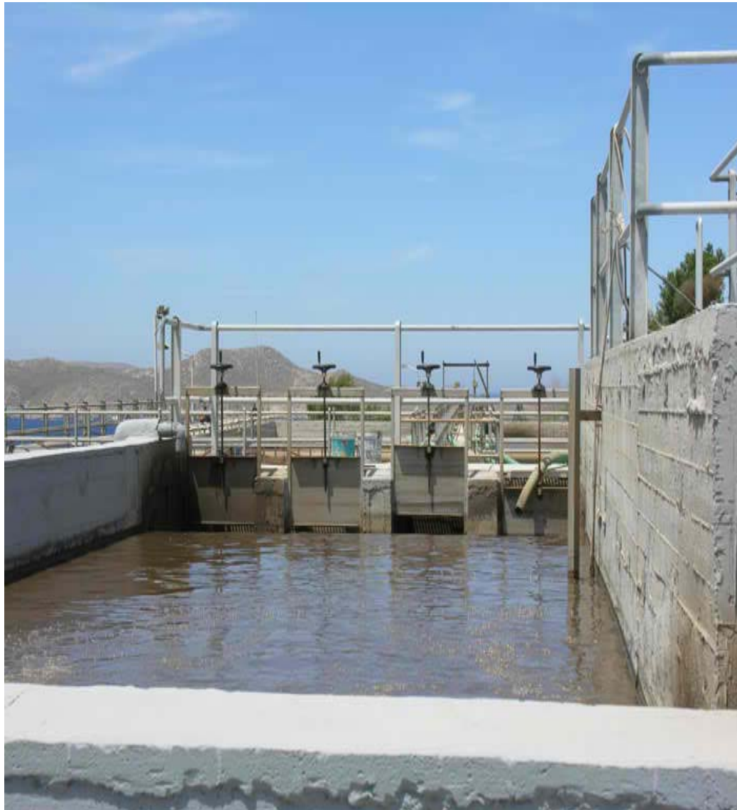
Εικόνα 3.8. Εξαμμωτής με σταθερή ταχύτητα ροής ( www.google.gr/images )
