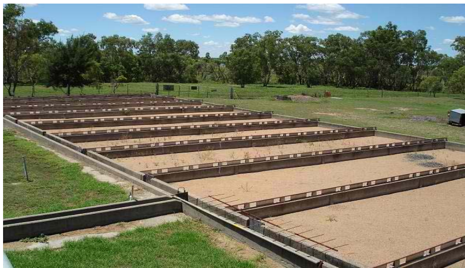
Εικόνα 3.16. Ιλύς σε κλίνες ξήρανσης. (www.google.gr/images)
