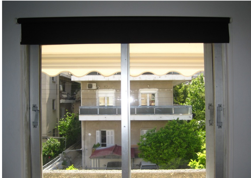
Εικόνα 3.3: Αλουμινένιο συρόμενο κούφωμα παλαιού τύπου
