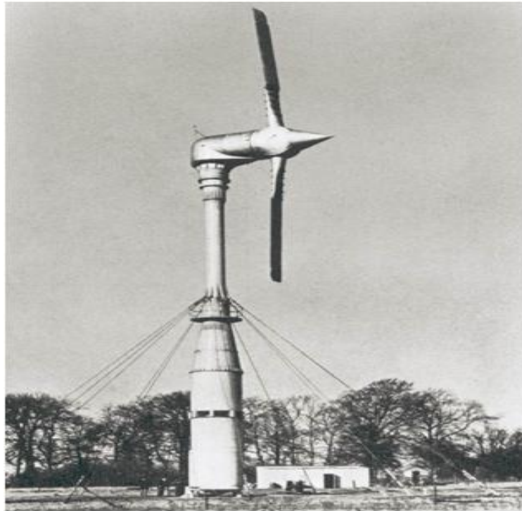
Σχήμα 3.4 Ανεμοκινητήρας οριζοντίου άξονα τύπου Andreau-Enfield
