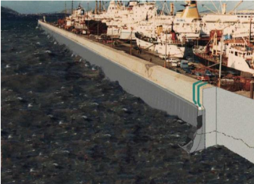
Εικόνα B)I.1.2)1 : Προτεινόμενη κυματοθραυστική εφαρμογή του μετατροπέα κυματικής ενέργειας WECA.
