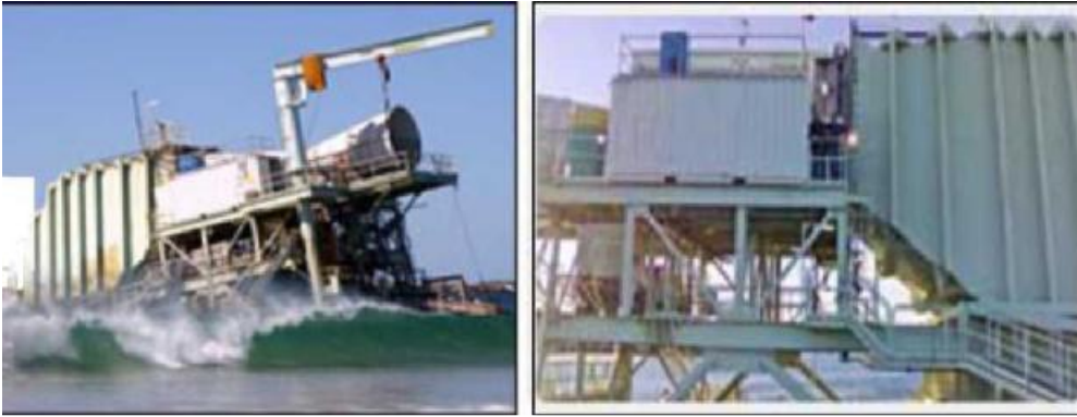
Εικόνα Β)III.1.2)2 : Η συσκευή Oceanlinx σε λειτουργία και ένα κοντινό πλάνο της απόληξης του κωνοειδούς θαλάμου αέρα της που καταλήγει στον στρόβιλο Denniss-Auld της συσκευής Oceanlinx.
