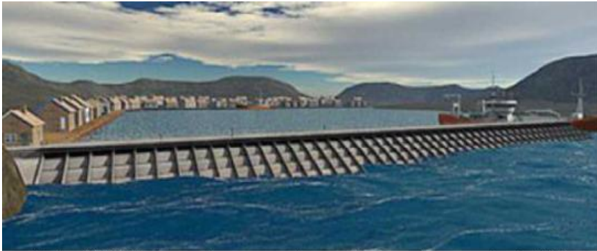
Εικόνα Β)Ι.2.1)2 : Προτεινόμενη κυματοθραυστική εφαρμογή της τεχνολογίας SSG.
