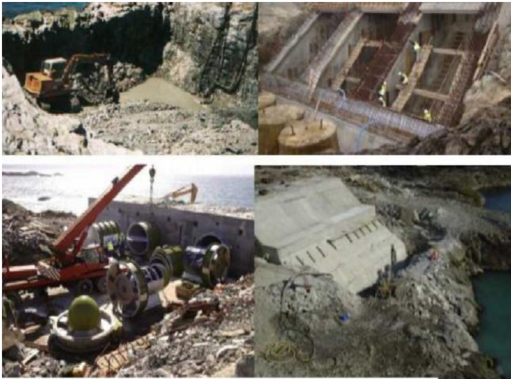
Εικόνα Β)Ι.1.1)3 : Διάφορα στάδια κατασκευής της εγκατάστασης LIMPET στο νησί του Islay. Στη πρώτη φωτογραφία φαίνεται η αρχική εκσκαφή της επιλεγμένης τοποθεσίας εγκατάστασης, στη δεύτερη η κατασκευή των 3 τσιμεντένιων αεροθαλάμων, στη τρίτη φαίνεται η συναρμολόγηση του συστήματος παραγωγής ηλεκτρικής ενέργειας με τον στρόβιλο Wells και τις επαγωγικές γεννήτριες και στη τέταρτη η τελική μορφή της πρόσοψης της εγκατάστασης. της εγκατάστασης.
