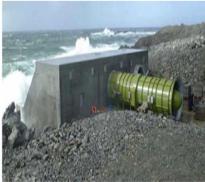
Εικόνα Β)1.1.11 : Η ολοκληρωμένη εγκατάσταση παραγωγής ηλεκτρικής ενέργειας LIMPET στο νησί του Islay.
