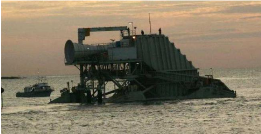
Εικόνα Β)III.1.2)1 : Η πρωτότυπη μονάδα Oceanlinx των 450kW στο Port Kembla της Αυστραλίας.
