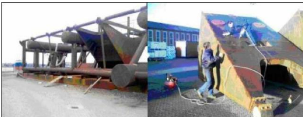
Εικόνα Β)III.5.1)3 : Στάδια κατασκευής του μοντέλου Poseidon's Organ κλίμακας 1:6. Στην πρώτη φωτογραφία φαίνεται ένα τμήμα της πλατφόρμας με ένα πλωτό πτερόγιο και μια αντλία ενσωματωμένα, ενώ στη δεύτερη φαίνεται η δοκιμή πίεσης σε ένα από τα πλωτά πτερόγια.
