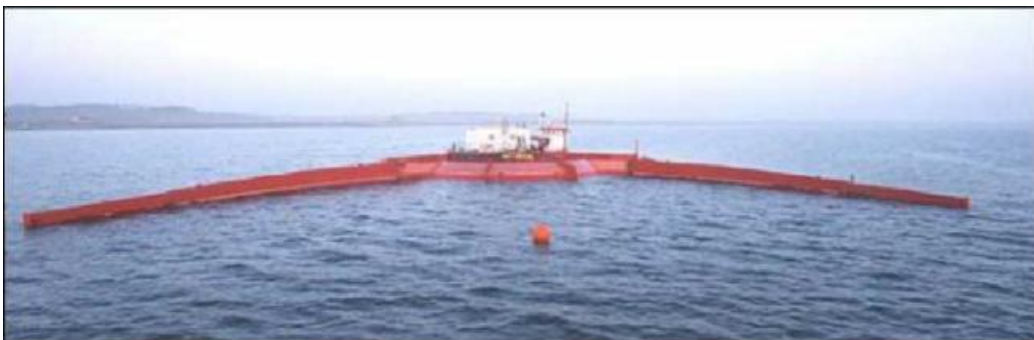
Εικόνα Β)III.2.1)3 : Η πρόσοψη του μετατροπέα Wave Dragon στο Nissum Brending. Διακρίνονται οι ανακλαστήρες των θαλάσσιων κυμάτων, δεξιά και αριστερά από το κύριο τμήμα υπέρβασης και μετατροπής.
