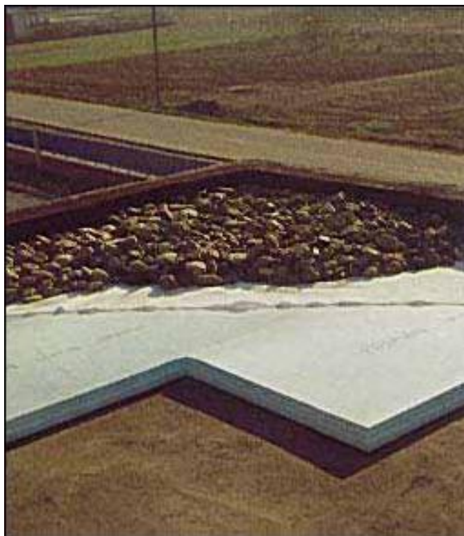
Εικόνα 1.7: Παράδειγμα μόνωσης οροφής σε υφιστάμενο κτίριο.
