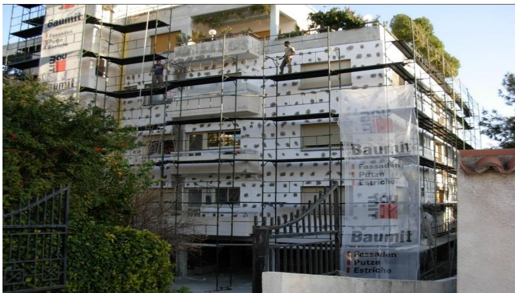
Εικόνα 4.2 : Τοποθέτηση μόνωσης σε εξωτερικούς τοίχους.(πηγή KNAUF)
