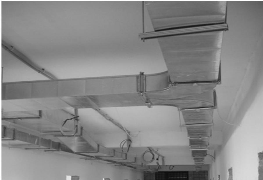
Σχήμα 5.4: Εγκατάσταση ορθογωνικού αεραγωγού στην οροφή
