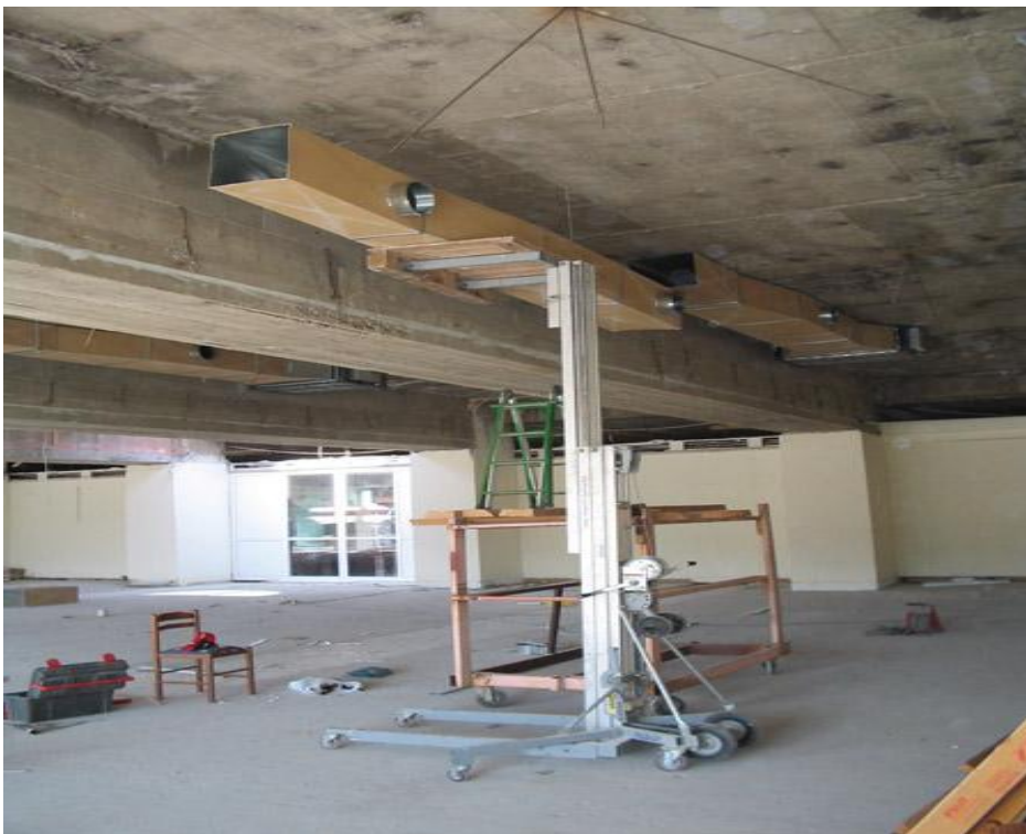
Σχήμα 5.3: Αεραγωγός ορθογωνικής διατομής
