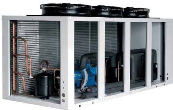
Σχήμα 1.58: Αξονικοί ανεμιστήρες σε ένα ψυκτικό συγκρότημα.
