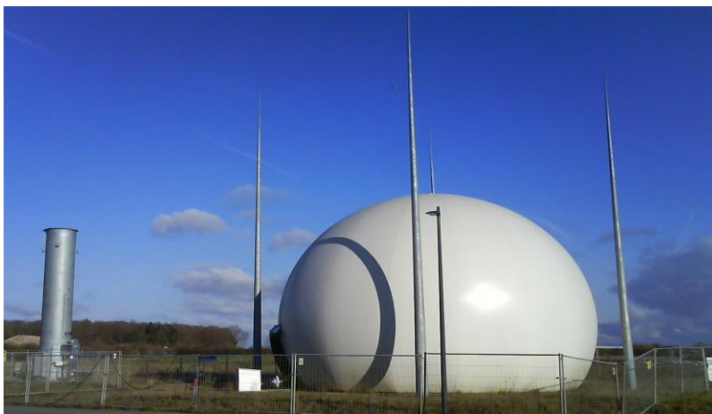
Εικόνα 3.2: Αντιδραστήρας Αναερόβιας Χώνευσης ( www.microbiokosmos.org )
