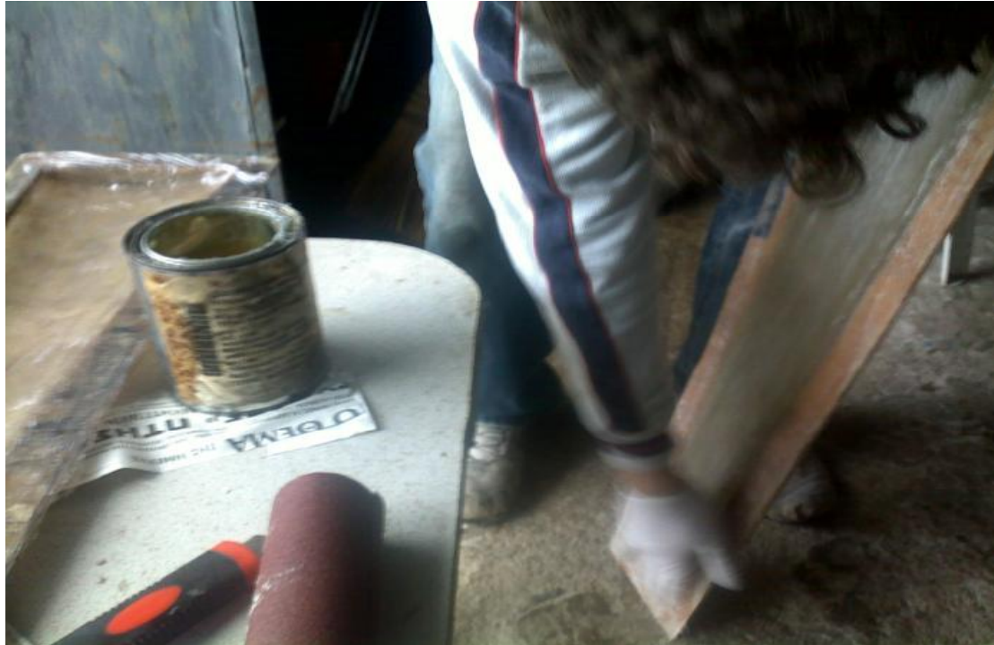
Εικόνα 11.5.1: Επάλειψη με αντικολλητικό.
