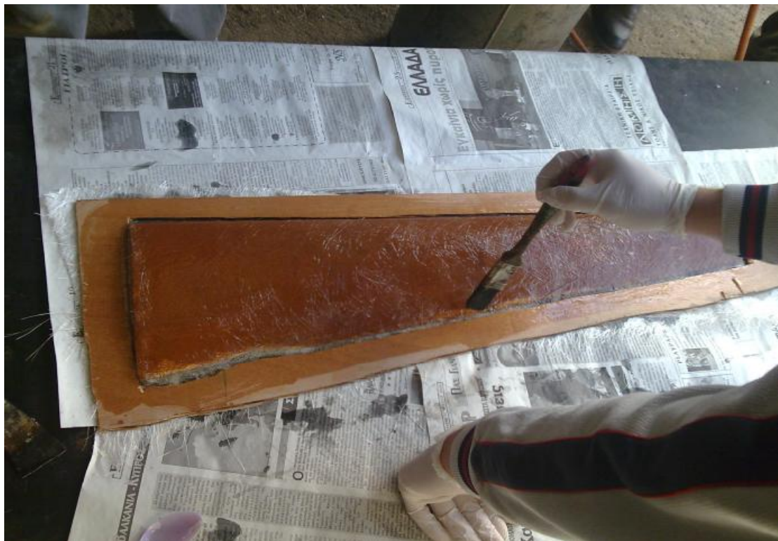
Εικόνα 11.4.2.4 Κατασκευή καλουπιού. Τελικό πέρασμα με πολυεστέρα.
