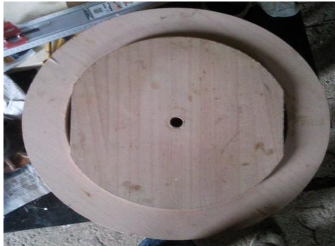
Εικόνα 12.2.4.4: Τοποθέτηση του εσωτερικού καλουπιού μέσα στο εξωτερικό
