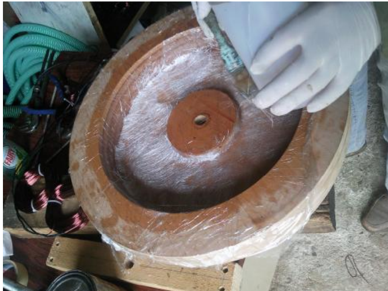
Εικόνα 12.2.9.5: Τοποθέτηση υαλονήματος στο πάτο και στα τοιχώματα
