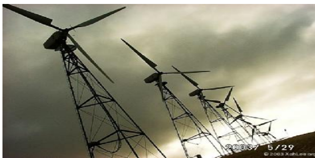
Σχήμα 6.4.8.1.1: Ανεμογεννήτριες με δικτυωτό πύργο Πηγή: www.strandedwind.org
