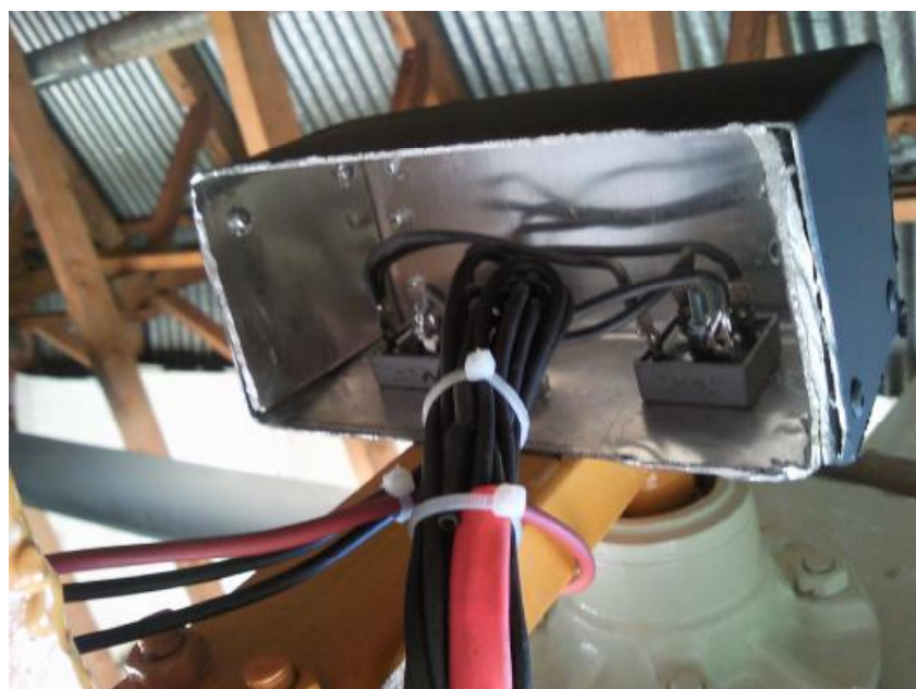
Εικόνα 3.5.1: Τοποθέτηση κυκλωμάτων στο κουτί-ψήκτρα
