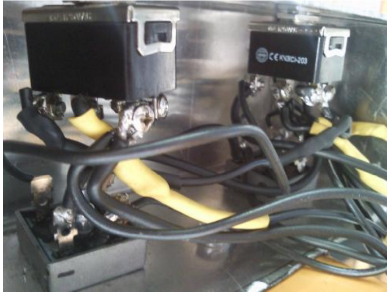
Εικόνα 3.5.2: Τοποθέτηση κυκλωμάτων στο κουτί-ψήκτρα
