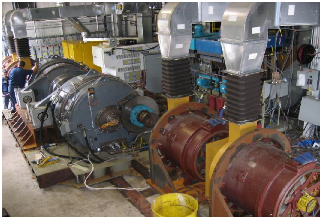
Σχήμα 6.4.2.2: Κιβώτιο ταχυτήτων ανεμογεννήτριας 1,5 MW κατά τη κατασκευή του. Πηγή: www.hapeman.com
