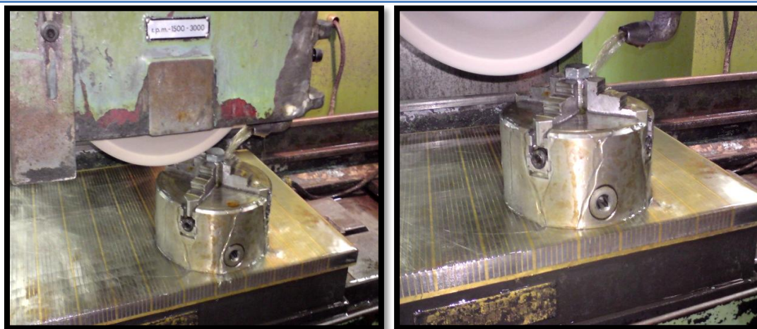
Εικόνα 15 : Λείανση στηριγμάτων (κοχλίες) πλάκας
