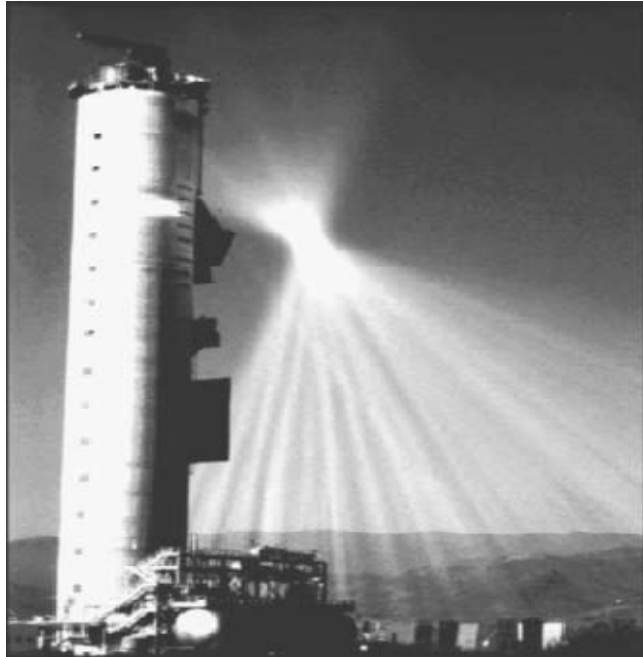
Σχήμα 4 : Πλάγια όψη του τσιμεντένιου πύργου ύψους 80 m της μονάδας CESA-1 στην εγκατάσταση Plataforma Solar de Almería στην Ισπανία
