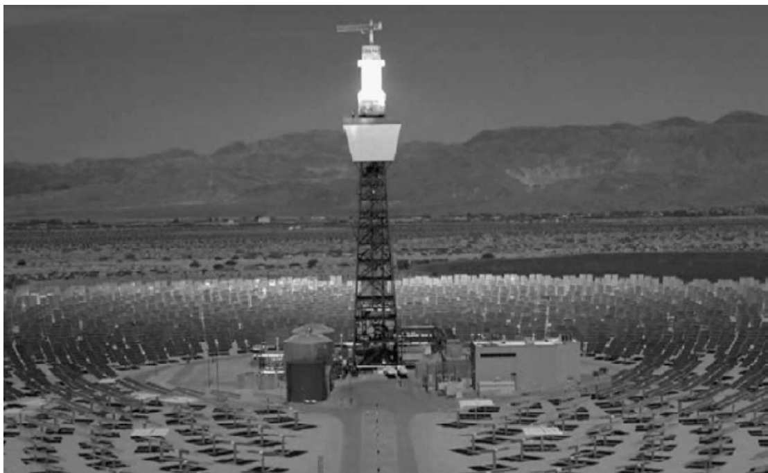
Σχήμα 10: Εναέρια φωτογραφία από το σταθμό ηλεκτροπαραγωγής πύργου ισχύος 10MW, Solar Two
