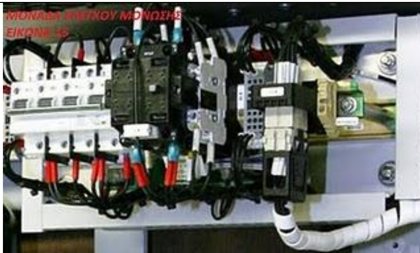
Εικόνα 3.5: Μονάδα έλεγχου μόνωσης EBW
