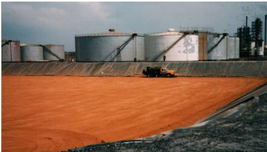
Σχήμα 4.8 : Παράδειγμα εφαρμογής land farming
