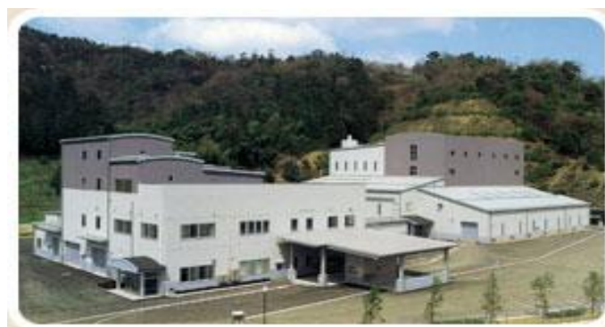
Σχήμα 4.31 : Εγκατάσταση αεριοποίησης ΑΣΑ στην Ιαπωνία (Sharma & Reddy, 2004, Geoenvironmental Engineering Wiley)
