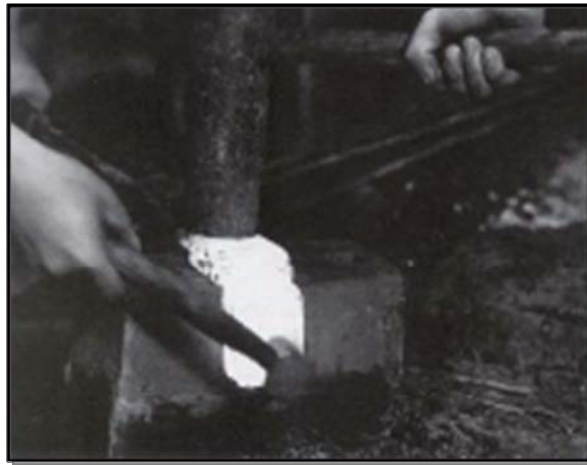
Εικόνα 3.8: Εκ νέου αναδίπλωση του χάλυβα
