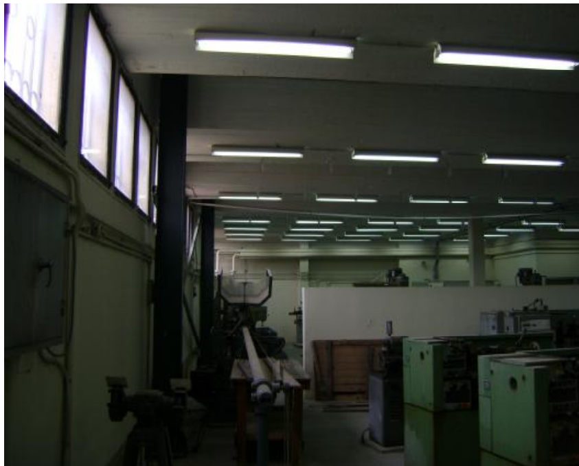
Φωτογραφία 2.1 : Δομή κτιρίου.
