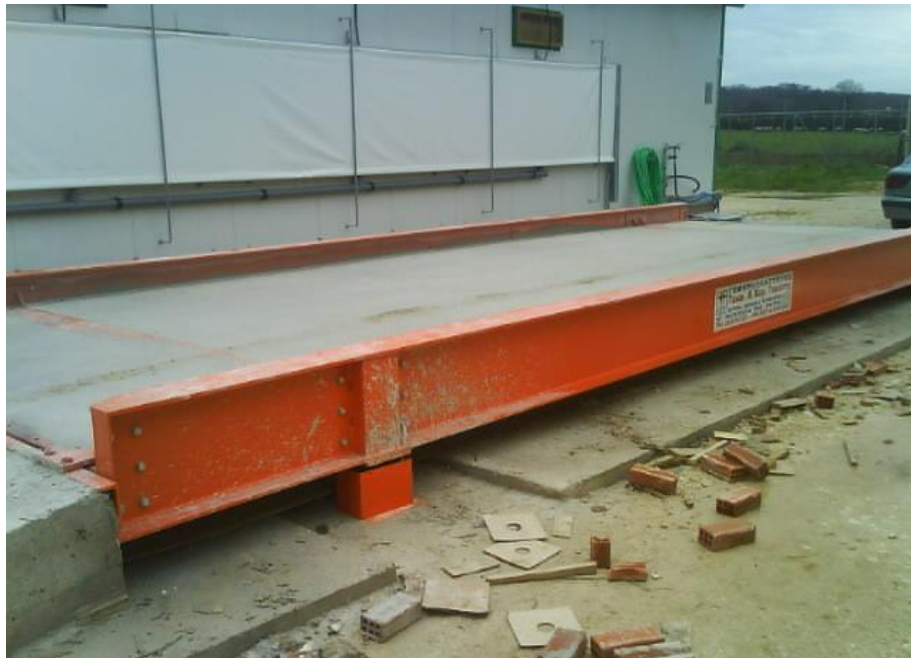
Εικόνα 2.2: Ηλεκτρονική γεφυροπλάστιγγα μεικτής κατασκευής επιφανειακής τοποθέτησης.
