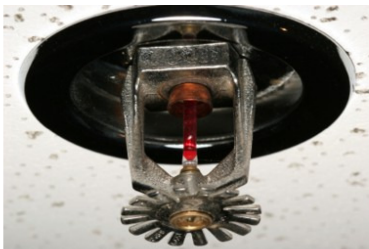
Εικόνα 3.1: Τύπος καταιονητήρας
