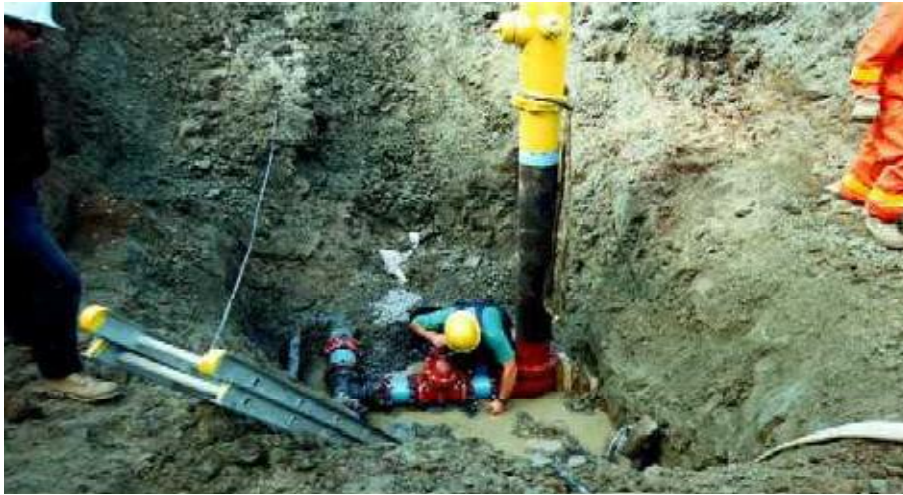
Εικόνα 3.1: Ερευνητική εκσκαφή εντοπισμού διαρροής.
