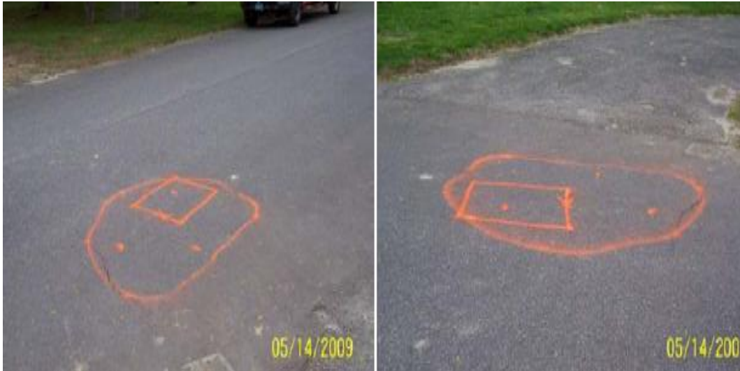
Εικόνα 4.3 : Ακριβής προσδιορισμός σημείου διαρροής
